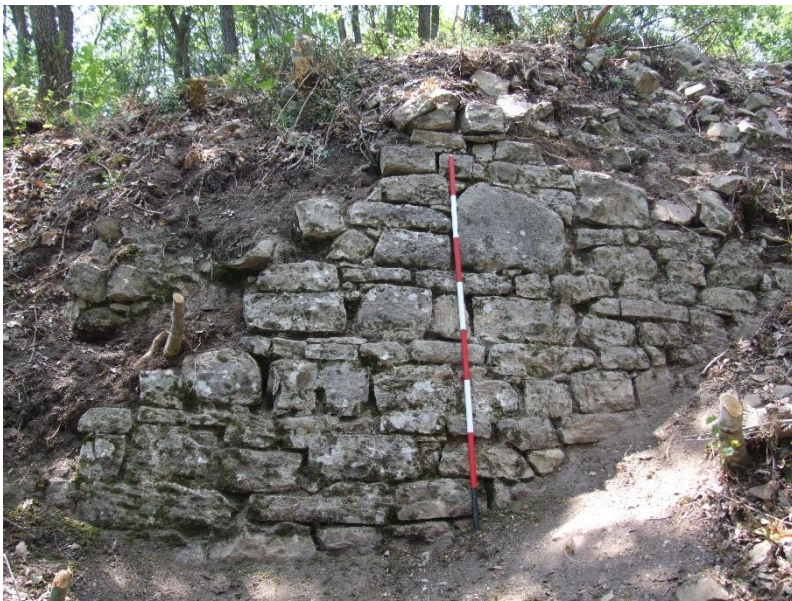
Fig. 4. Sant'Elia a Pianisi, muro di terrazzamento del castello di Pianisi (foto C. Ebanista).
