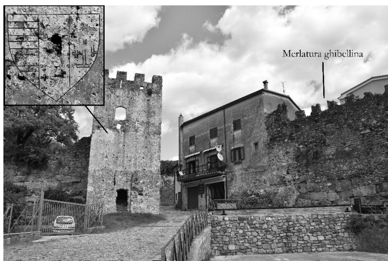
Fig. 11. Policastro Bussentino, l'angolo sud-ovest del circuito murario (D. Sica).
