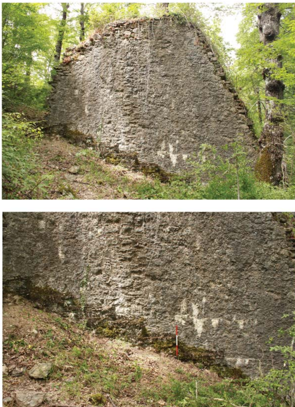
Fig. 9. Mulino del Sagittario: zoccolatura a gradoni (Foto V. Vitale)
