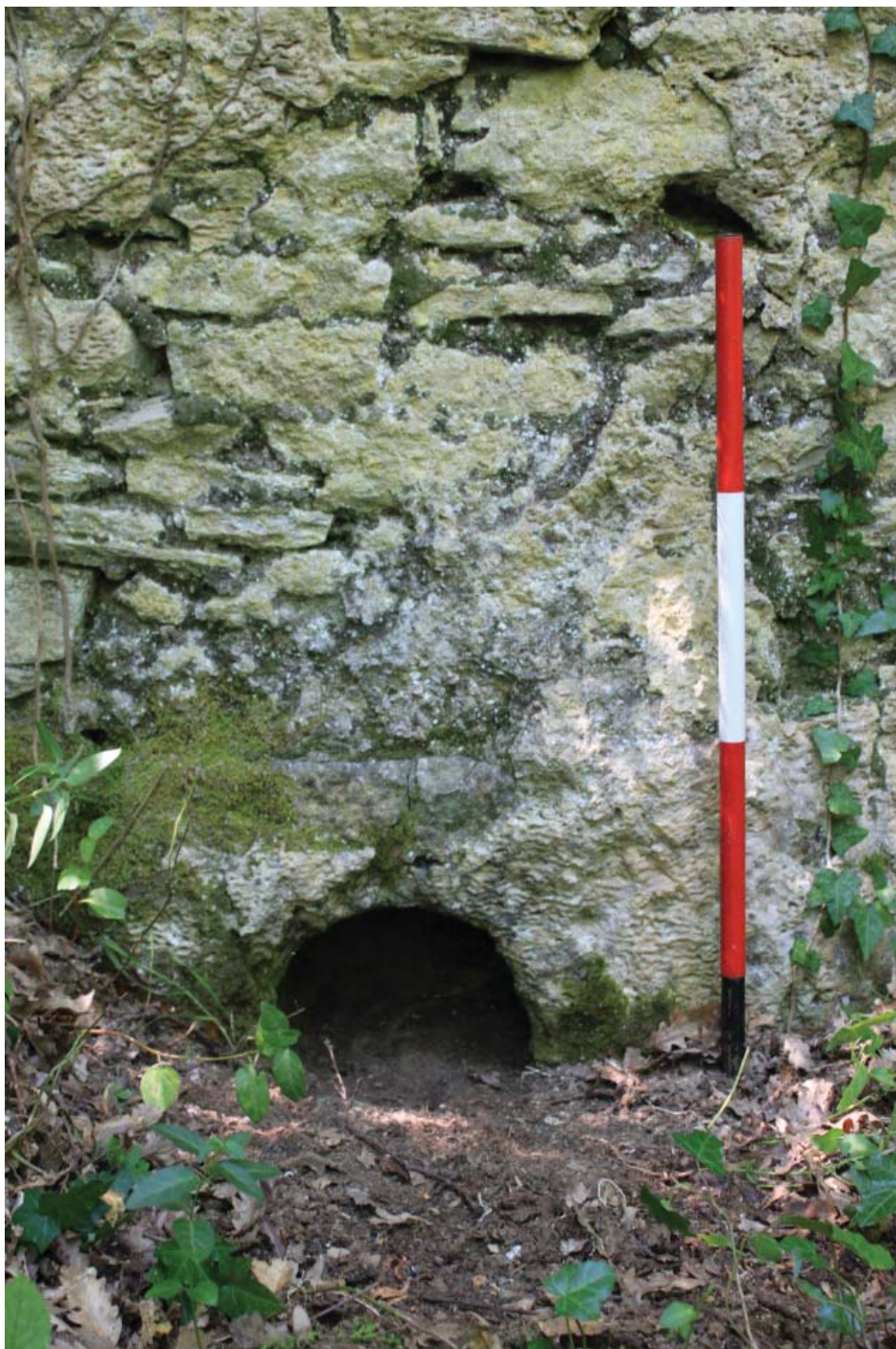
Fig. 4. Opificio idraulico del Sagittario: bocchetta immissione acqua (Foto V. Vitale)
