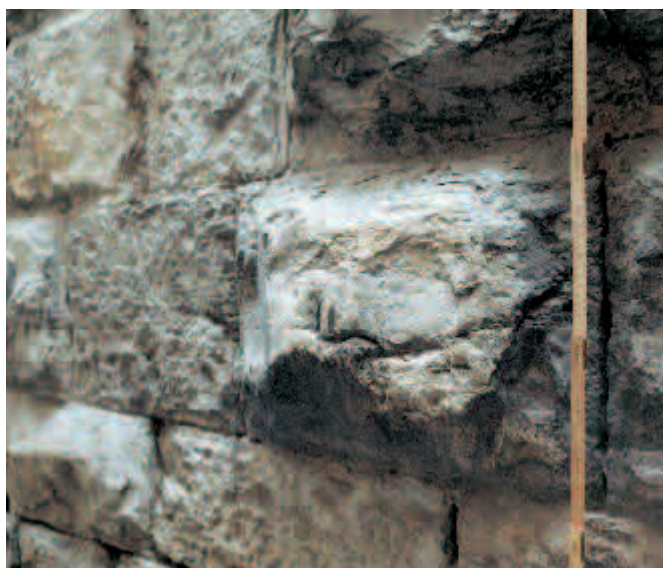
Fig. 22. Genova, chiostro di San Lorenzo, dettaglio della muratura con alternanza di conci spianati e in bugnato «rustico».
