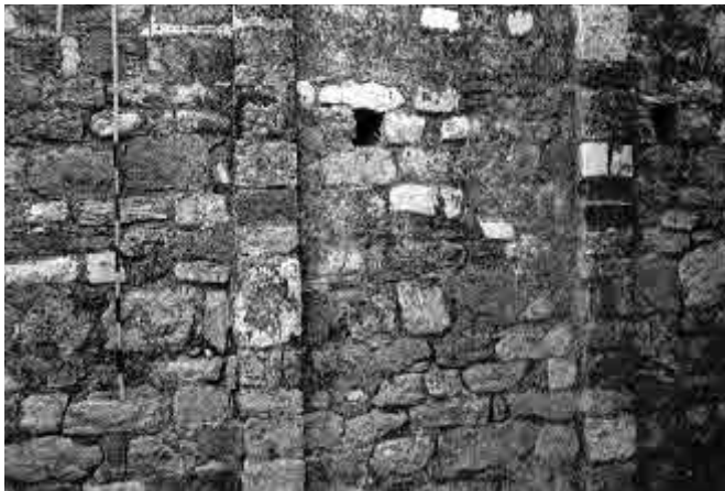
Fig. 7. Muratura di tipo D (San Paragorio di Noli, Savona, prima metà dell'XI secolo)
