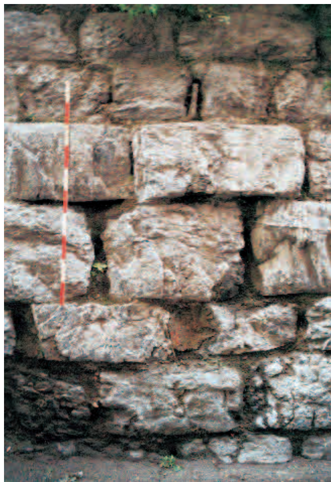
Fig. 16. Genova, tratto delle mura visibili in piazza Sarzano: dettaglio dei giunti
