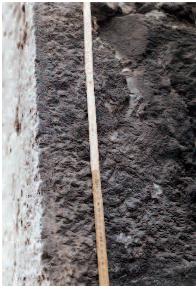
Fig. 14. Porta di Santa Fede, enova, dettaglio della rifilatura a scalpello di un conco d'angolo
