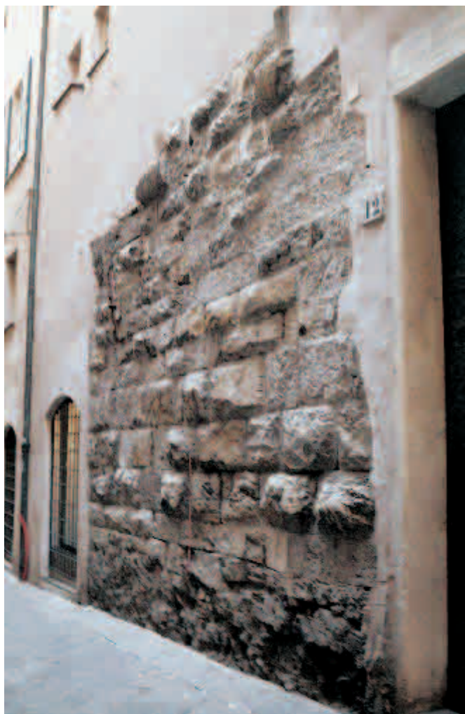
Fig. 20. Genova, chiostro di San Lorenzo (terzo quarto del XII secolo), muro perimetrale
