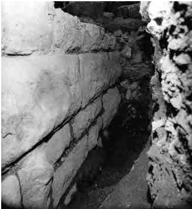
Fig. 10. Muratura in opera quadrata del Molo di San Marco (foto archivio Soprintendenza Archeologica della Liguria, n. E 19505)
