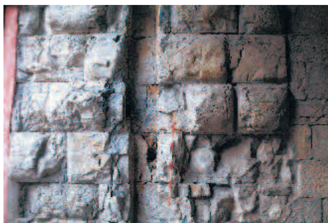
Fig. 18. Genova, torre degli Embriaci. Particolare della muratura in bugnato a cuscino
