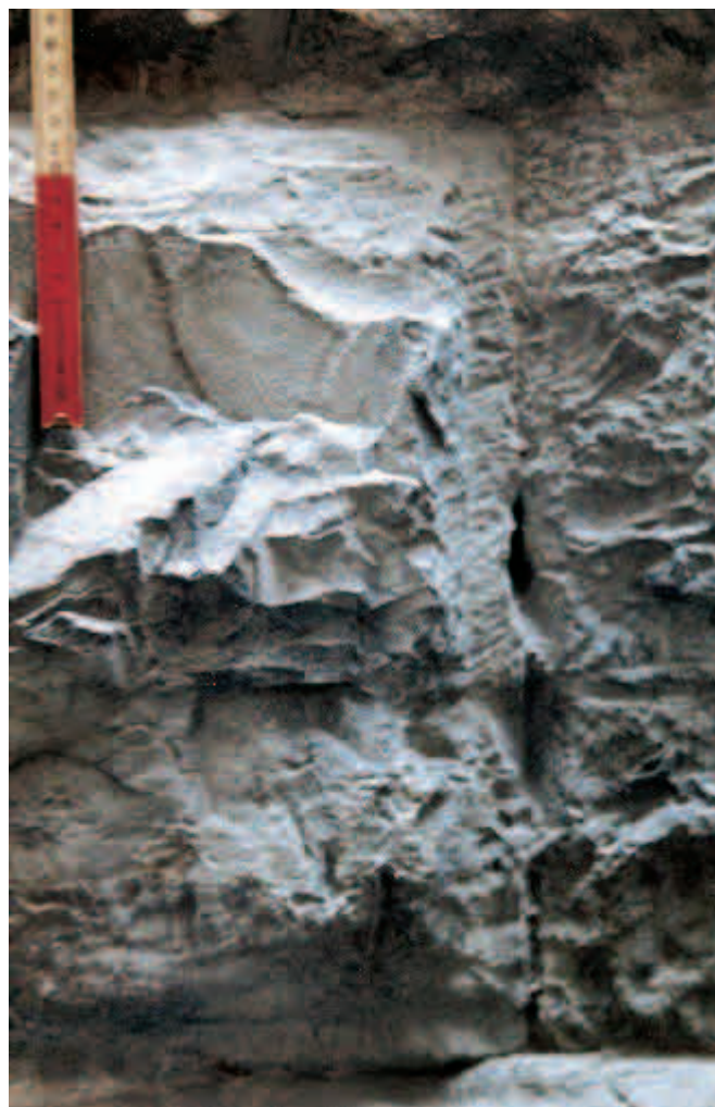
Fig. 21. Genova, chiostro di San Lorenzo, dettaglio della rifilatura a scalpello di un concio
