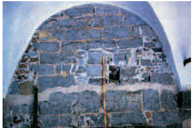
Fig. 8. Muratura di tipo D1 (palazzo vescovile di San Lorenzo, Genova, seconda metà XI secolo)
