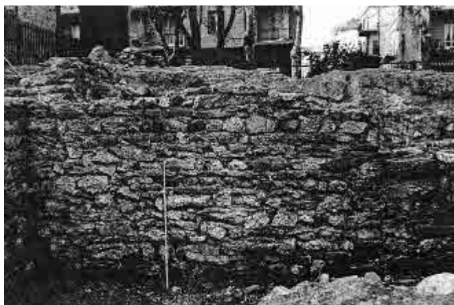
Fig. 3. Muratura di tipo B (Area archeologica di Alba Docilia . Savona, fasi tardoantiche)
