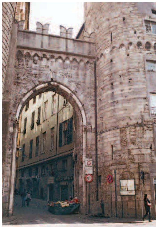
Fig. 11. Dettaglio della muratura a corsi bianco-neri della porta di Santa Fede (Genova, 1155-1160)
