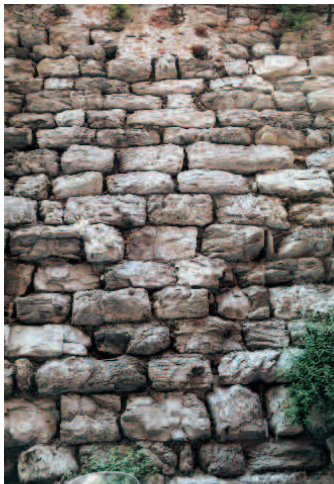
Fig. 15. Genova, tratto delle mura visibili in piazza Sarzano: la tecnica muraria in «pseudo opera quadrata»
