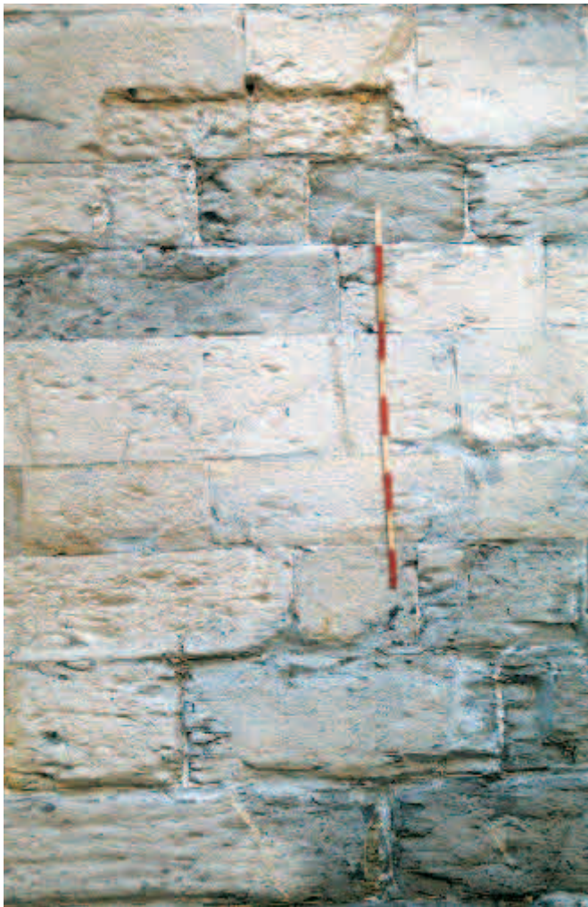
Fig. 25. Genova, complesso di San Giovanni di Pré: la muratura in opera quadrata
