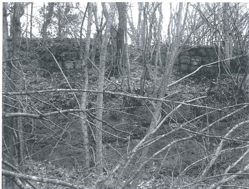
Porzione sud del muro difensivo.
