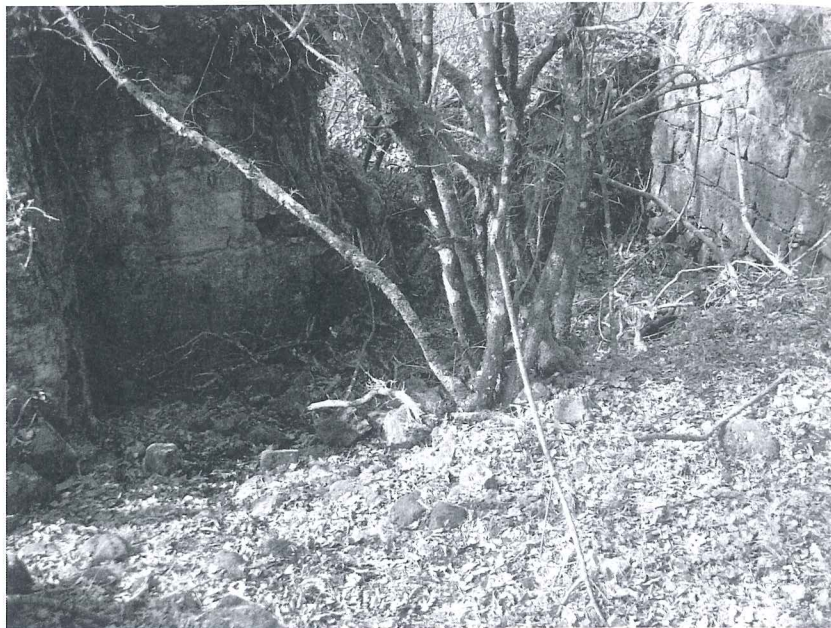
Ambiente sud-ovest dell'edificio signorile. A destra si riconosce il lato meridionale della torre.
