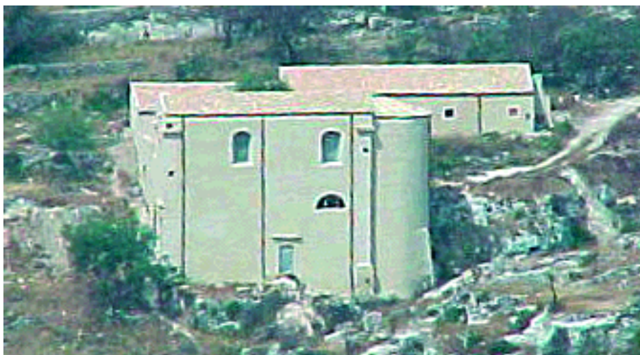
Chiesa e Convento di S. Sofia "a rassu" - sec XVI-XVIII (sopra e pagina accanto: prima del restauro; sopra: dopo il restauro)
