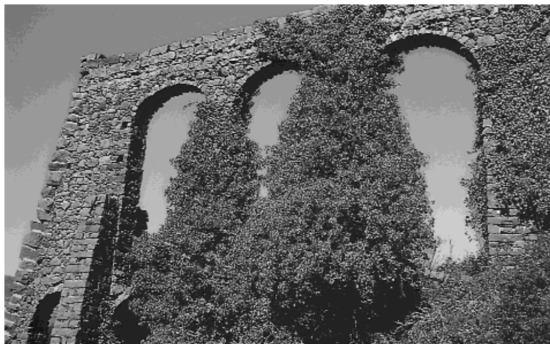
Resti di acquedotto detti “archi di Galia” - contrada Belingeri
