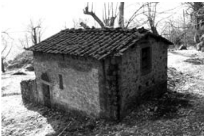
Figura 22: Il ‘seccoatoio’ medievale di Gravidona (in chiaro le strutture risalenti al XII - XIII secolo)
