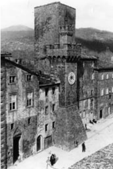
Figura 6: La piazza di castello di Santa Fiora in una foto d'epoca. In primo piano la torre dell'orologio (del 1382) e sullo sfondo la torre maggiore della rocca aldobrandesca (sec. XII)
