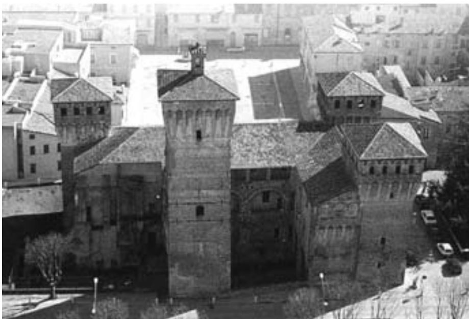
Foto 6 – Il castello di Finale Emilia, realizzato a partire dai primi anni del Duecento per iniziativa del comune di Modena, cui si deve la costruzione del mastio, allora affacciato sul corso del Naviglio (da: P. Belloi, E. Colombini, Castelli della provincia di Modena, Modena 2001, p. 191).
