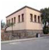
Baratili San Pietro, Lavatoio (foto F.D.)
