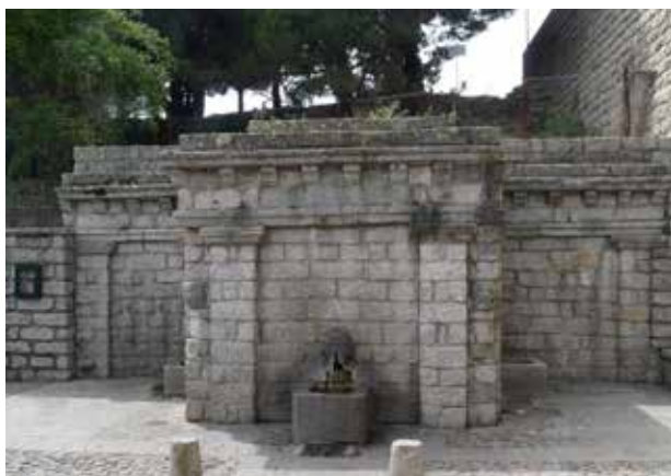
Fig. 11. Veduta d'insieme dell'area in cui sorge la Fontana di Pàstini di Tempio situata sotto il muro del terrapieno della ex-stazione ferroviaria, attuale via Carlo Avegno (foto: Dolores Corongiu, 2015).
