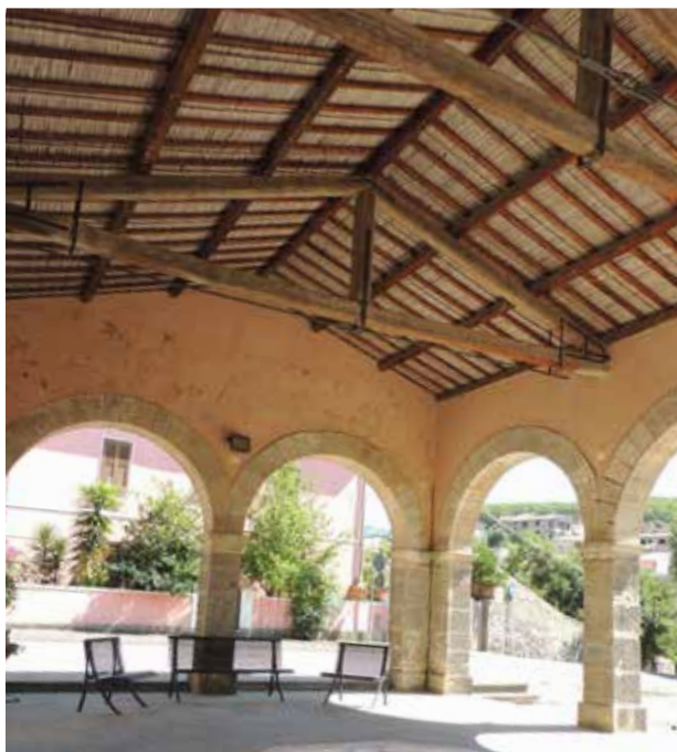
Fig. 11. Stato attuale del Lavatoio e orditura delle travi. Scano di Montiferro (foto: Valentina Mele).
