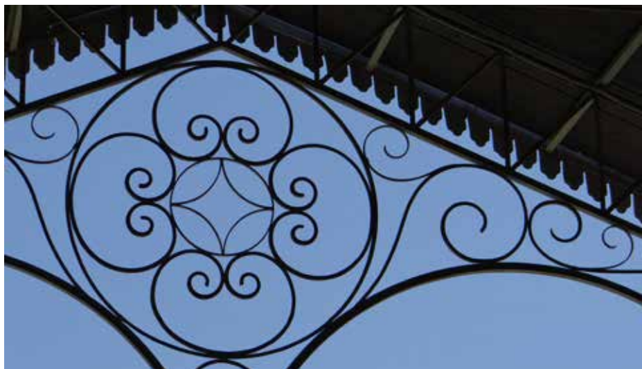
Fig. 10. Particolare delle decorazioni sotto le incavallature in ferro della copertura del lavatoio di Villacidro (foto: Stefano Mais).
