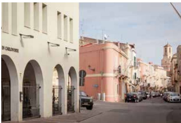
Fig. 6, Fig. 7. L'ex Cisternone oggi (foto: Stefano Ferrando).
