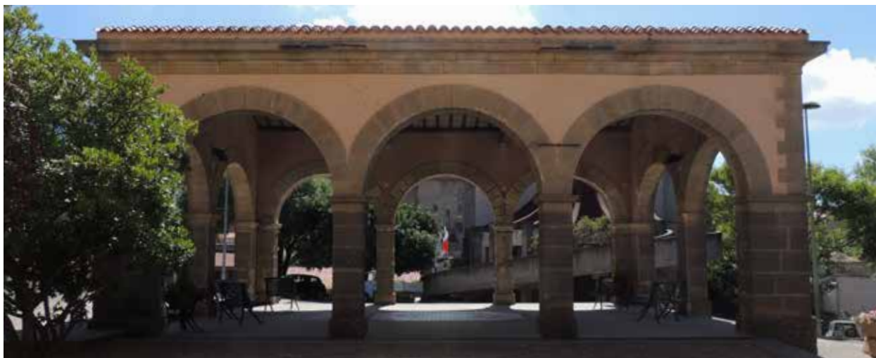
Fig. 10. Prospetto N-E del Lavatoio. Scano Montiferro (foto: Valentina Mele).
