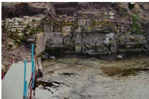
Fig. 8. La fontana durante il restauro, con il Rio Imbessu in piena (foto: arch. Francesco Masala).
