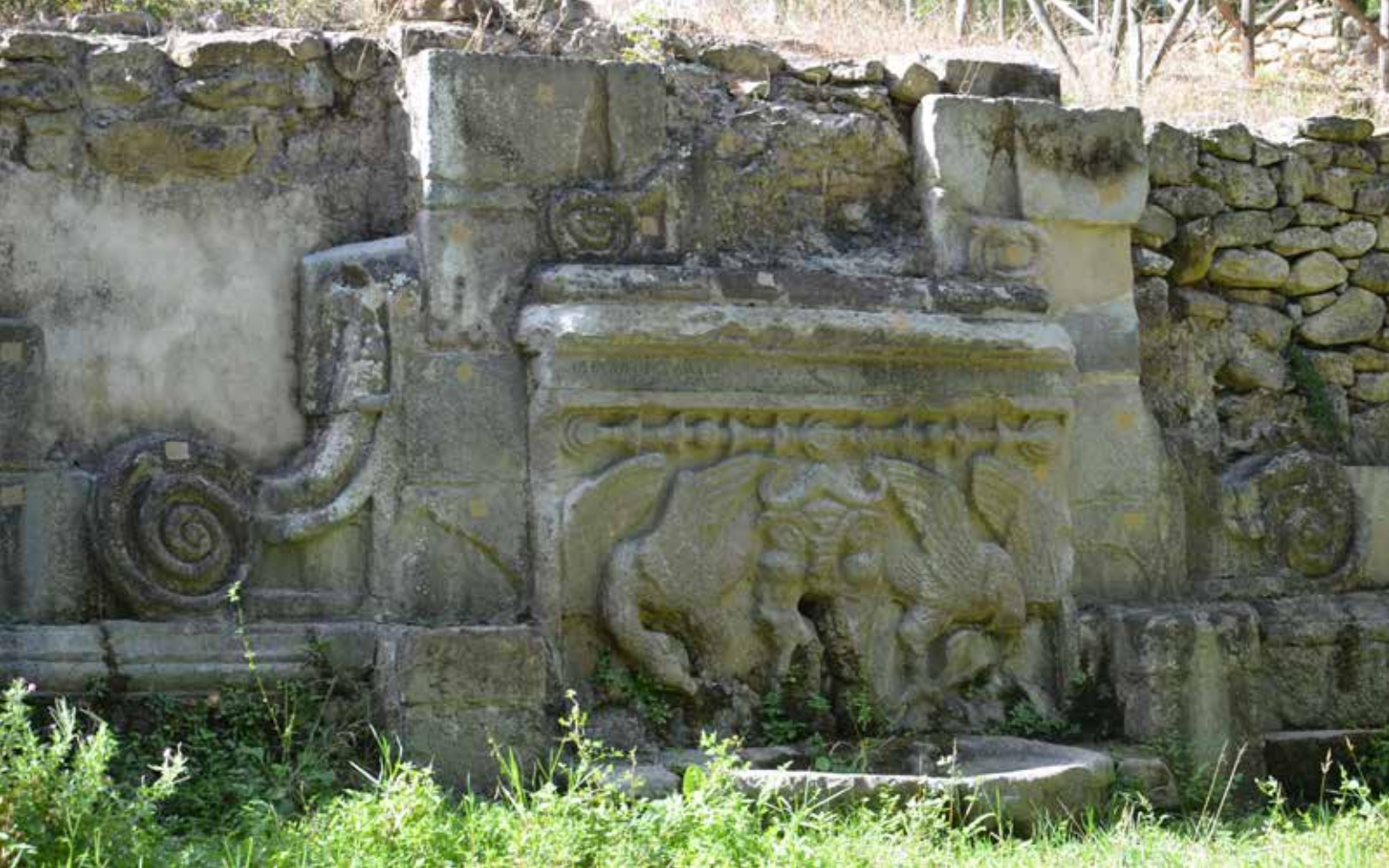
Fig. 2. La fontana dopo il restauro (foto: Raffaele Cau).
