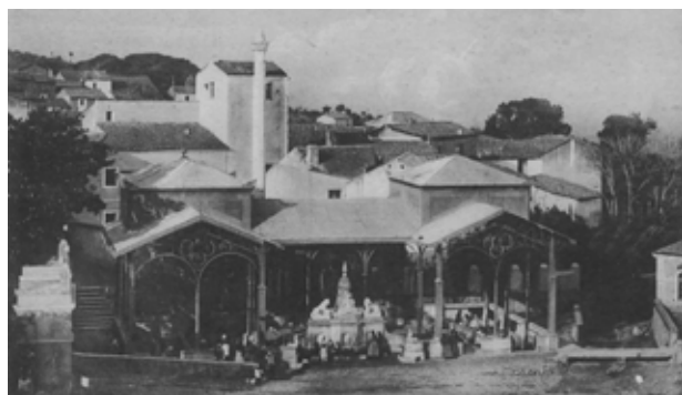
Fig. 9. Il lavatoio pubblico di Villacidro visto dall'alto in una foto di fine XIX secolo. Si scorge sulla destra l'alveo del rio Fluminera e il mattatoio pubblico (cartolina, archivio privato G. Cuccu, Villacidro).
