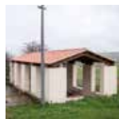
Martis, Lavatoio Sa Conza, 1932
