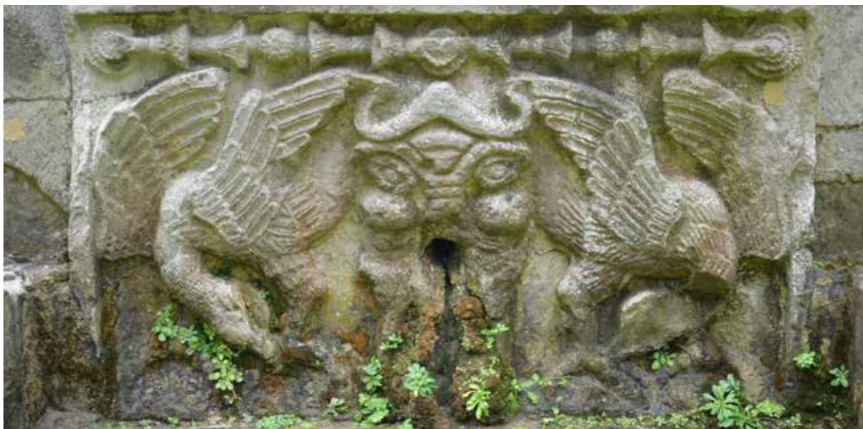
Fig. 5. Prospetto frontale del blocco con il mascherone e i cigni (foto: Raffaele Cau).
