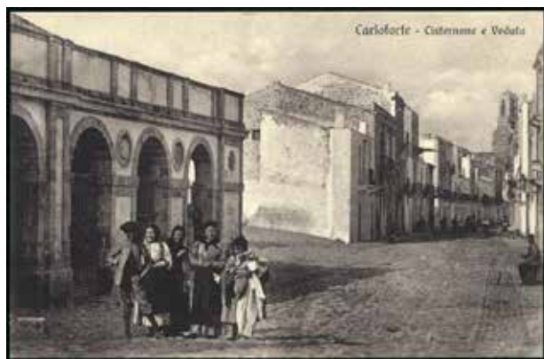
Fig. 4. Il Cisternone in una foto d'epoca; sullo sfondo il campanile della Chiesa Parrocchiale di San Carlo e la via XX Settembre (foto: ©Archivio ISRE, Collezione Colombini).
