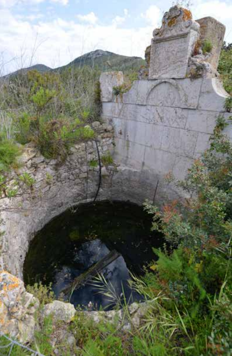
Fig. 5. Il bacino del pozzo e il prospetto della fonte. Sono evidenti al fianco dell'epigrafe le volute di recupero e il retrostante plinto (foto autore).
