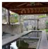
Aidomaggiore, Fontana Corte 'e Josso, lavatoio (foto M.C.)
