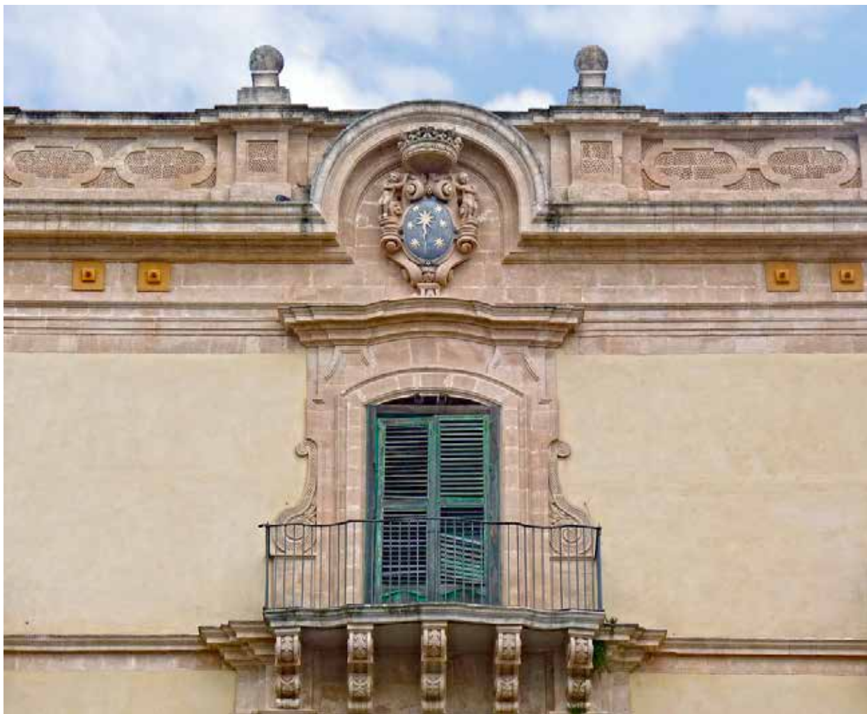
Fig. 9. Palazzo Polara a Modica, con la vistosa omega sulla cornice di coronamento.
