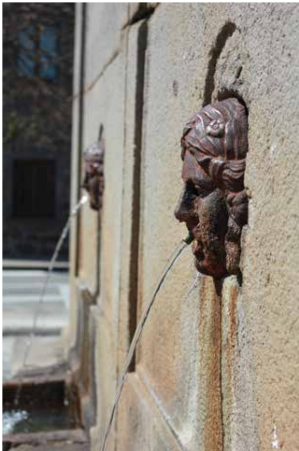
Fig. 8. Particolare delle bocche antropomorfe nel prospetto frontale della fontana Su Cantaru Mannu (foto: Nicola Floris). Si nota la doppia scanalatura della pietra dove trovavano collocazione i mascheroni originali.
