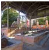
Villacidro, interno del lavatoio (foto S.M.)
