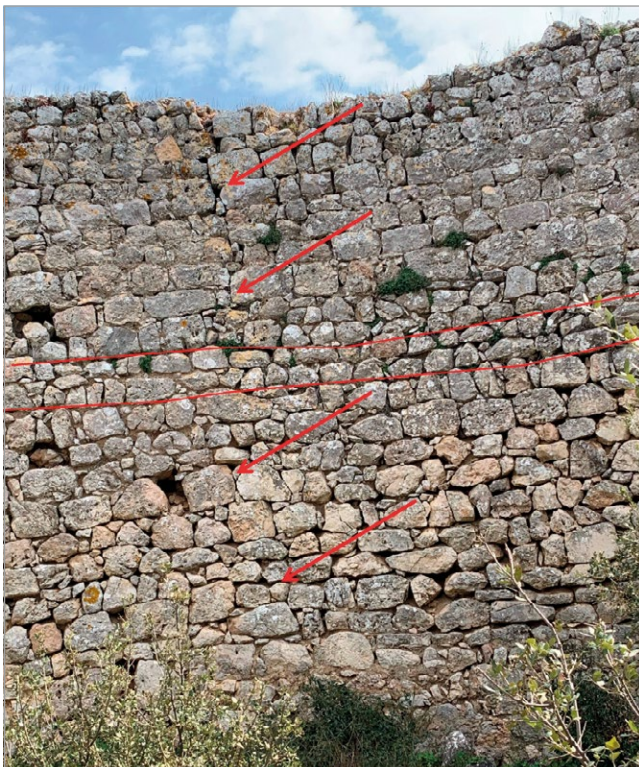
fig. 71 – Particolare della muratura interna del Tino di Moscona dove si nota la presenza di apparecchiature differenziate. La parte inferiore e superiore sono divise da due filari a formare una sorta di bancata in muratura. Nelle porzioni inferiori e superiori è comunque presente una cesura di accrescimento verticale in corrispondenza della quale si è, in seguito, creata una fessurazione.
