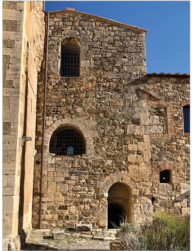
fig. 107 – La facciata della Sagrestia sul lato che si affaccia nel chiostro.
