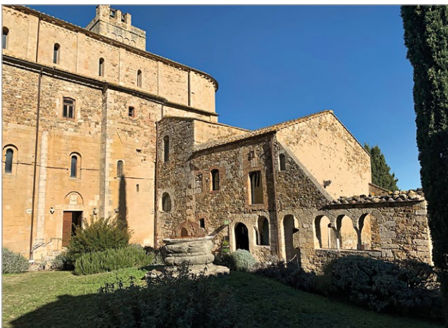
fig. 106 – La navata della chiesa abbaziale in appoggio alla facciata dell'attuale Sagrestia e accanto gli ambienti della Sala Capitolare.
