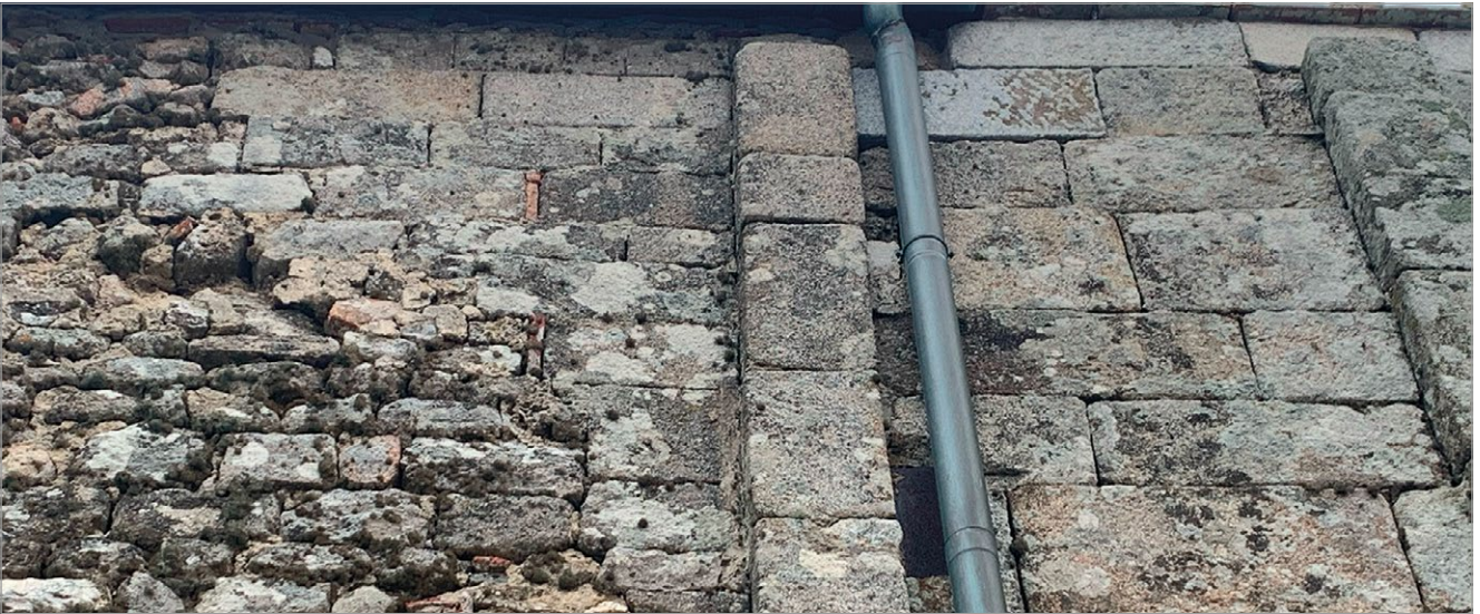
fig. 193 – Isola d’Elba, chiesa di S. Pietro. Particolare della porzione superiore del fianco sinistro nel punto in cui la muratura legata alla lesena di XII secolo si appoggia alla muratura sottostante.
