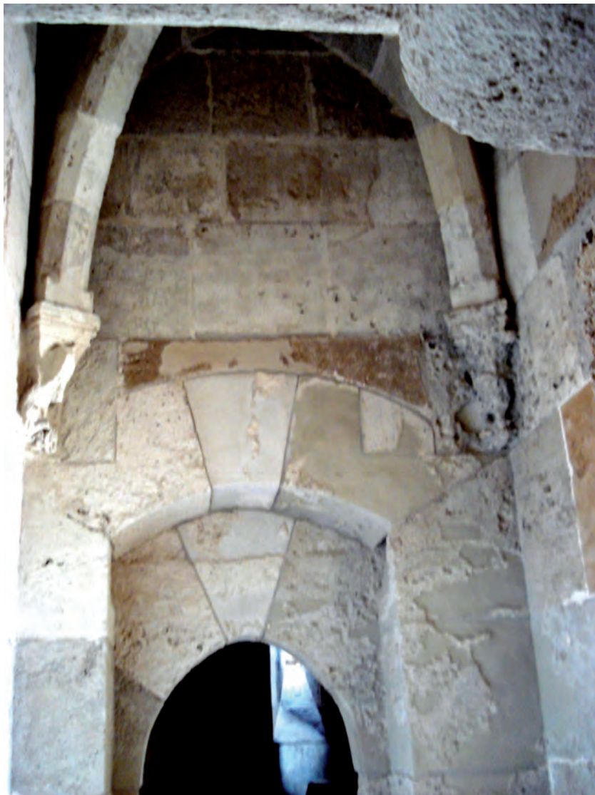
Fig. 17 - L'ingresso alla garderobe meridionale, visto dall'interno. Sono ancora conservati gli alloggiamenti (qui occlusi durante il restauro) per la trave in cui si incardinavano le ante
