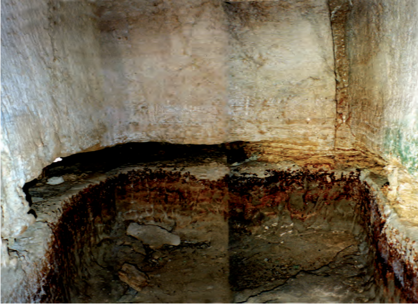
Fig. 49 - Il fotomontaggio (necessario per l'esiguità dello spazio) in cui si vede la punta estrema dell'incompiuto scavo operato nella roccia viva. Il vuoto orizzontale che si vede nella roccia è quello che rimane di uno strato di pietra argillosa asportata nel corso dei secoli dai marosi che battono dall'esterno. A sinistra si scorge uno spiraglio di luce proveniente dall'esterno
