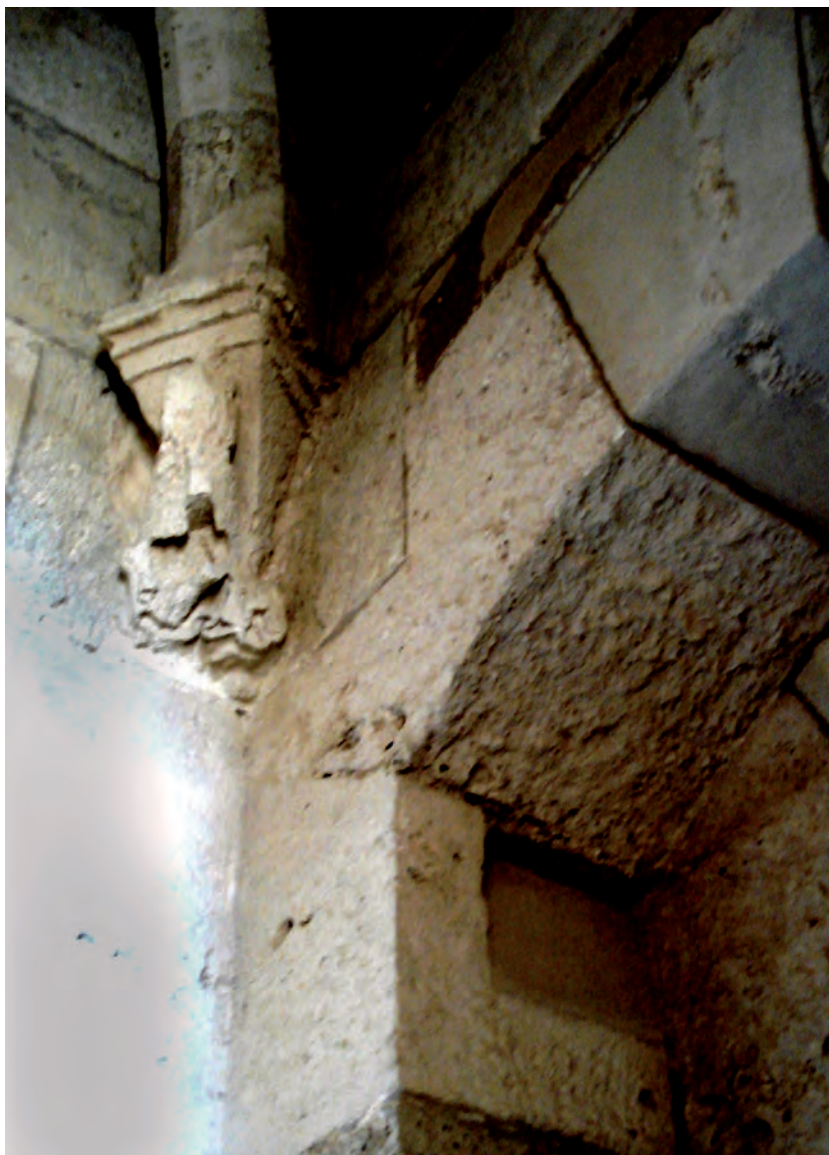
Fig. 19 - I resti della mensola su cui poggia un costolone nella garderobe meridionale, al lato destro entrando; sono ancora visibili soltanto i brandelli goticeggianti delle vesti appartenenti a un personaggio oramai del tutto scomparso
