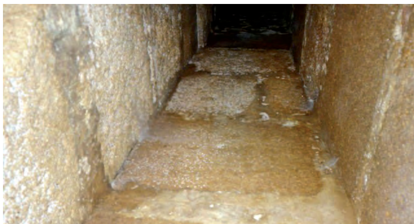
Fig. 51 - Castello di Augusta; l'interno della canna di scarico di una delle garderobes ubicate nella torre mediana occidentale. Visto lo stato perfetto in cui si ritrova oggi la muratura, si evince che l'impianto ben presto dovette cadere in disuso
