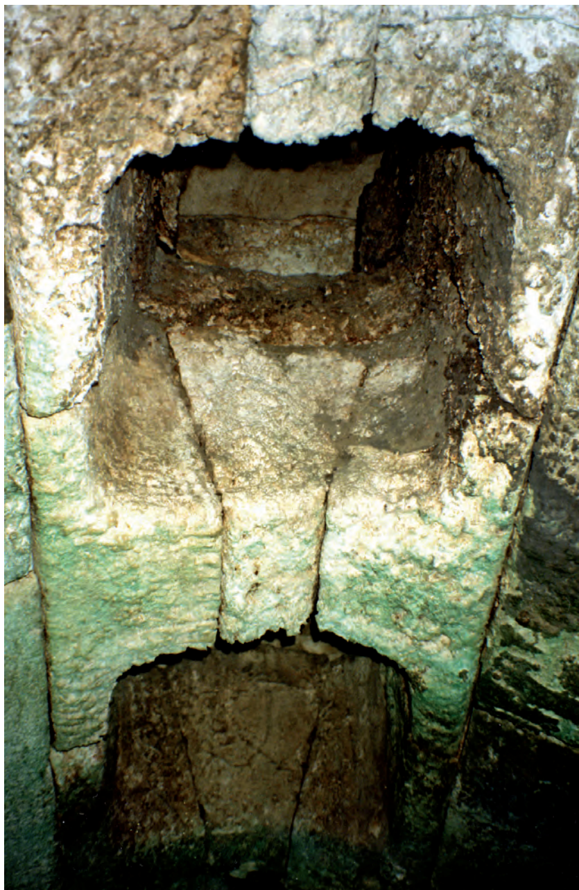
Fig. 32 - Gli sbocchi inferiori di due delle tre canne di scarico che attraversano la volta che copre la cloaca orientale
