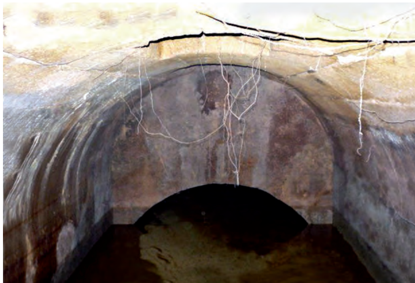
Fig. 50 - Castello di Augusta; la cloaca scoperta di recente sotto la torre mediana occidentale mostra la sua bellissima struttura in pietra conca accuratamente lavorata. Nella volta a pieno centro si notano le aperture di sbocco delle due canne di scarico delle garderobes situate ai piani superiori
