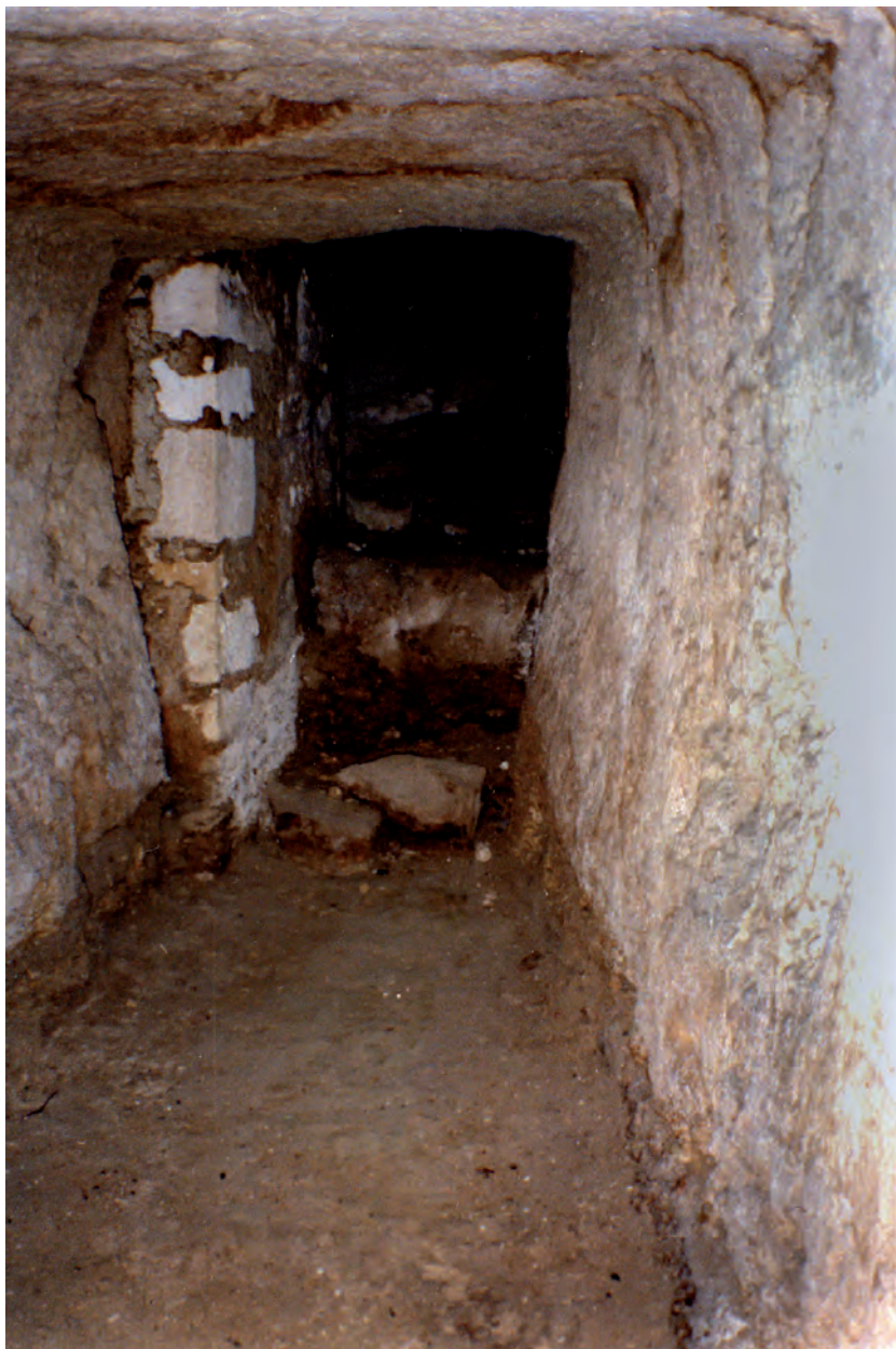
Fig. 47 - Il cunicolo scavato nella roccia viva (sullo sfondo è la camera della cloaca) che avrebbe dovuto portare le deiezioni verso il mare aperto
