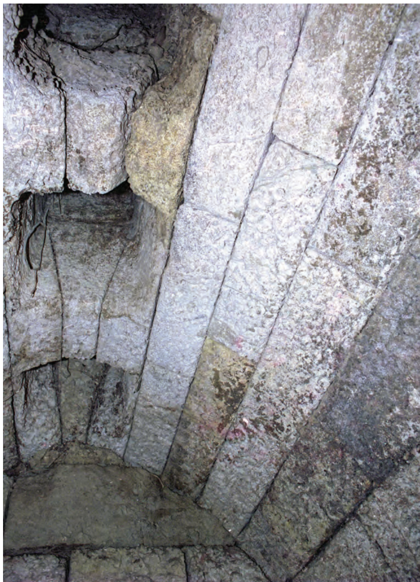
Fig. 37 - Lo sbocco delle tre canne di scarico nella volta della cloaca meridionale
