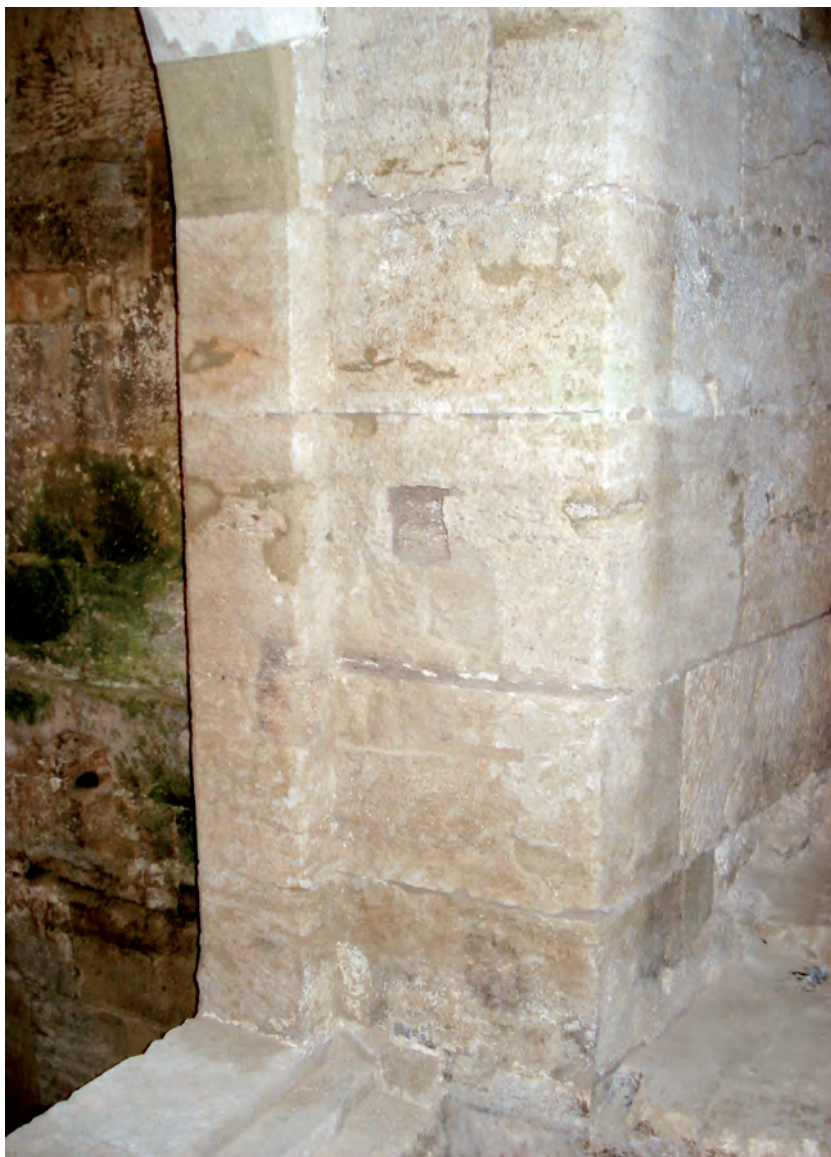
Fig. 8 - L'interno del vestibolo che porta alla torre sud. A destra si vede lo stipite della porta verso la sala ipostila. Si noti il foro (oggi occluso) dell'alloggiamento creato per la trave-serraglia; dalla sua distanza dal battente, si può dedurre lo spessore delle ante di chiusura
