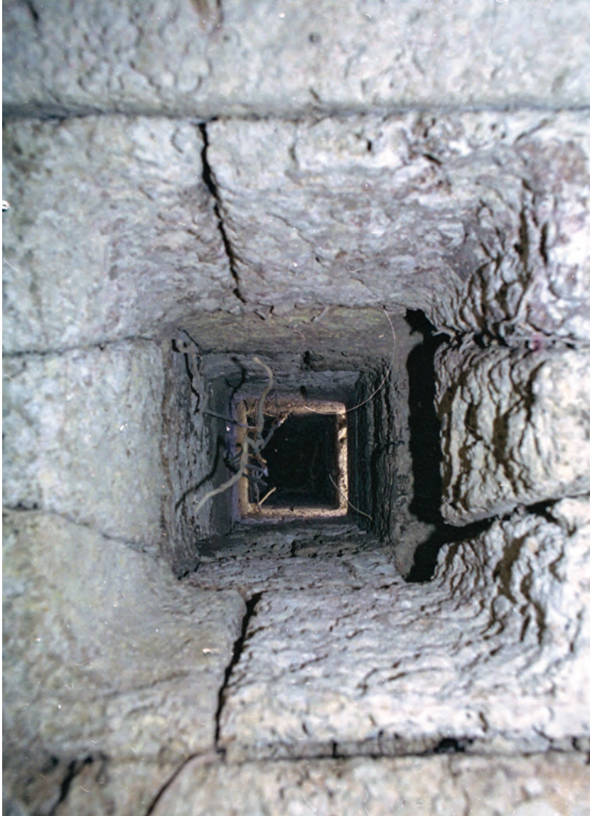
Fig. 37 bis - Iposcopia dell'interno di una delle canne di scarico nella cloaca meridionale
