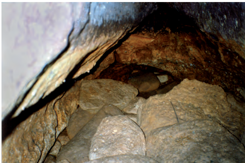
Fig. 42 - Interno del cunicolo formato scavando e allargando con lo scalpello la fenditura naturale. In primo piano si vedono dei grossi conci, quasi tutti arrotondati dalla furia del mare che li ha sospinti dentro il cunicolo
