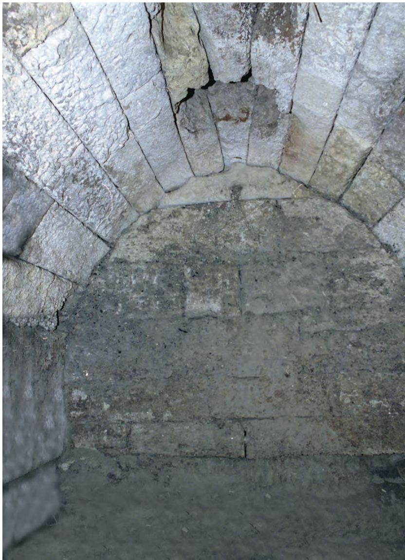
Fig. 36 - Il lato sinistro della volta nella cloaca meridionale. Si noti che la parte inferiore del muro poggia direttamente sulla roccia spianata
