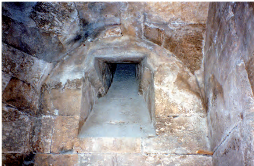
Fig. 11 - Pianerottolo inferiore: vista dall'interno della complessa 'finestra' e del ripido e lunghissimo cunicolo che la collega con l'esterno
