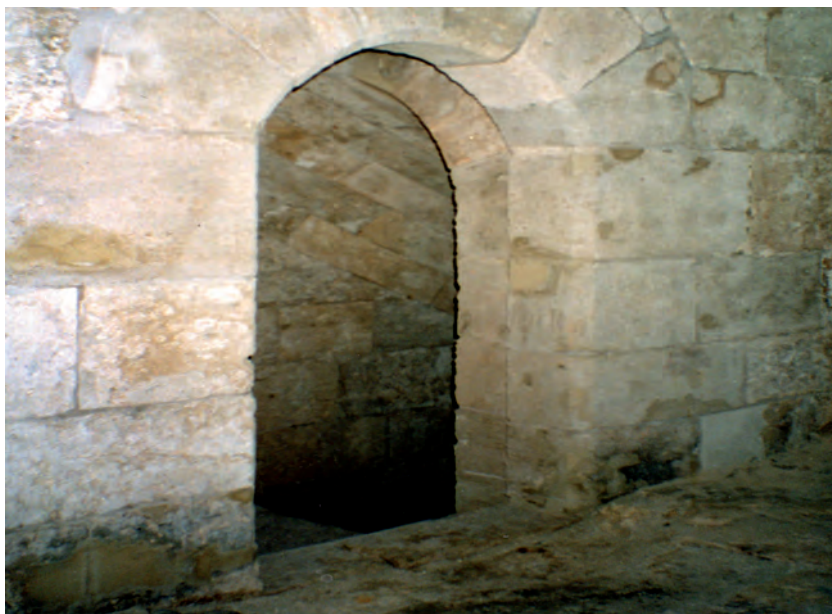
Fig. 7 - L'accesso originario alla scala era dato da un'unica porta d'ingresso ubicata all'interno della grande sala ipostila. Si notano le pesanti modifiche apportate al suo arco nel Settecento, quando fu inglobato nella nuova struttura edilizia.
