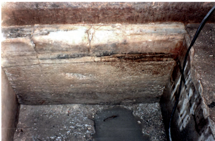
Fig. 17 - La vasca svuotata: la sponda laterale (di roccia?) si vede coperta da un massello di cipollino alto oltre 20 cm e palesemente ricavato da una colonna; a destra si vede la lastra della sponda anteriore, posta alla fine e sotto l'ultima breve rampa di scale.
