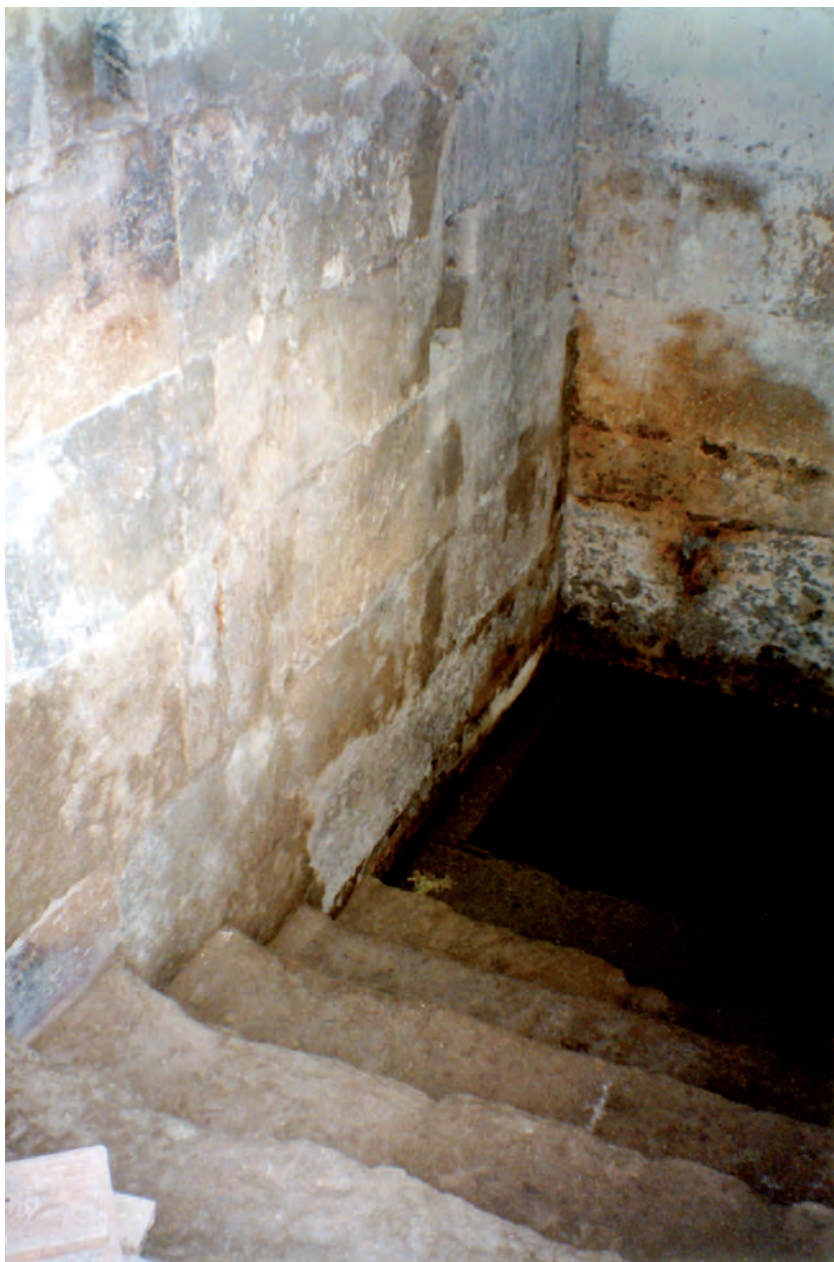
Fig. 22 - La vasca del c.d. Bagno della Regina, piena d'acqua, il cui livello supera il bordo superiore della stessa. In primo piano è l'ultima rampa di scale, palesemente inserita in un vuoto preesistente.
