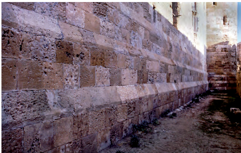
Fig. 4 - La parete sud-occidentale del Castello (sul Porto Grande): si vedono la posa della prima fila dei conci posati direttamente sulla roccia appositamente spianata e le tre robuste riseghe alla base che ispessiscono la base della muraglia.
