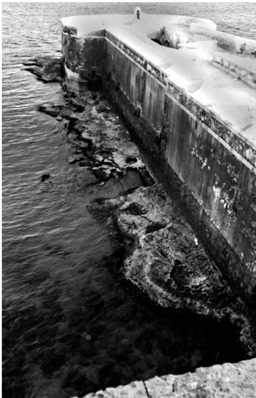
Fig. 35 - Resti di lavorazioni nel banco di roccia, attualmente in parte sommersi
