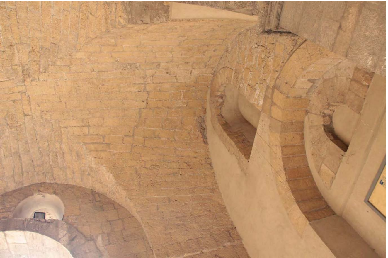
5: Torre quadrata (Colleville): dettaglio della volta nell'ambiente sud.
