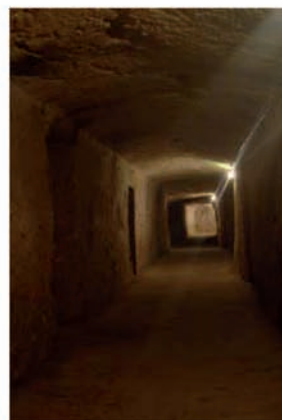
Fig. 1.4 - Corridoio del rifugio antiaereo
