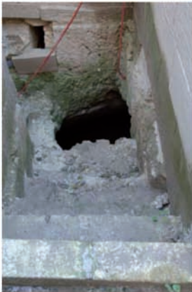
Fig. 8.32 - Ipogeo 15. Scalinata d'accesso
