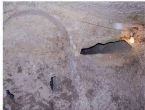
Fig. 6.12 Ipogeo 2. Corridoio E. Dettaglio
