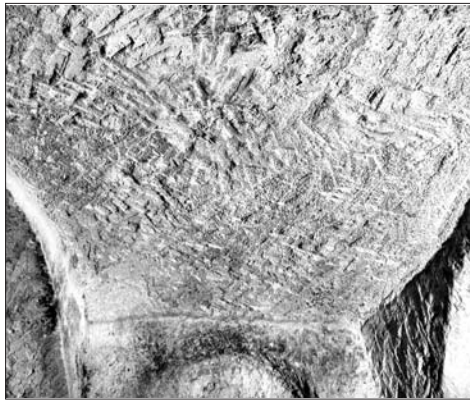
Fig. 35 - Settore C. Tomba a baldacchino n. 3, soffitto interno
