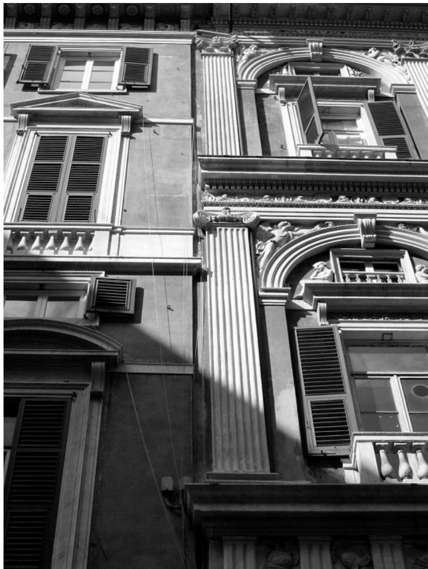
Fig. 13 - Palazzi Sauli e Solari, poi palazzo della Banca Nazionale di Sconto, prospetto verso via San Lorenzo, particolare dell'attacco tra le due costruzioni originarie.
