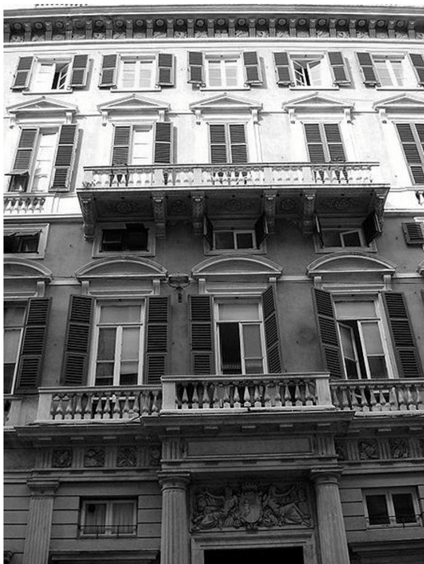
Fig. 12 - Palazzo Sauli, poi palazzo della Banca Nazionale di Sconto, prospetto lungo la Carrettiera Carlo Alberto (attuale via San Lorenzo), dettaglio.
