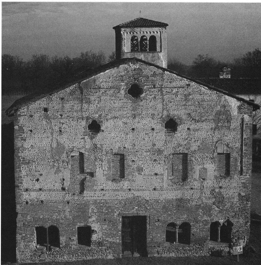
Fig. 4. Prospetto ovest dell'avancorpo addossato alla chiesa (foto G. Viazzo).
