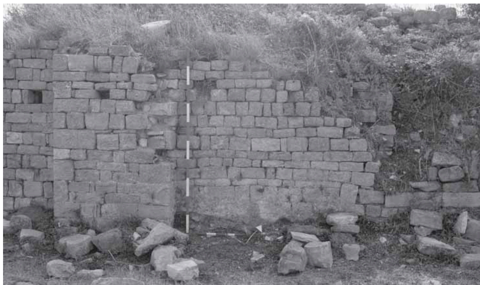
Fig. 12 - Particolare della muratura meridionale della basilica.
