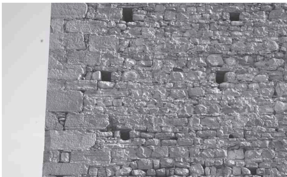
Fig. 8 - Particolare della muratura esterna nord della torre.
