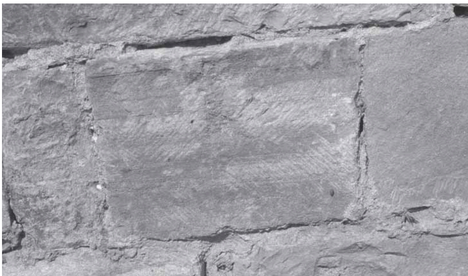
Fig. 14 - Particolare della lavorazione "a chevrons" dei blocchi impiegati nei muri della cappella.
