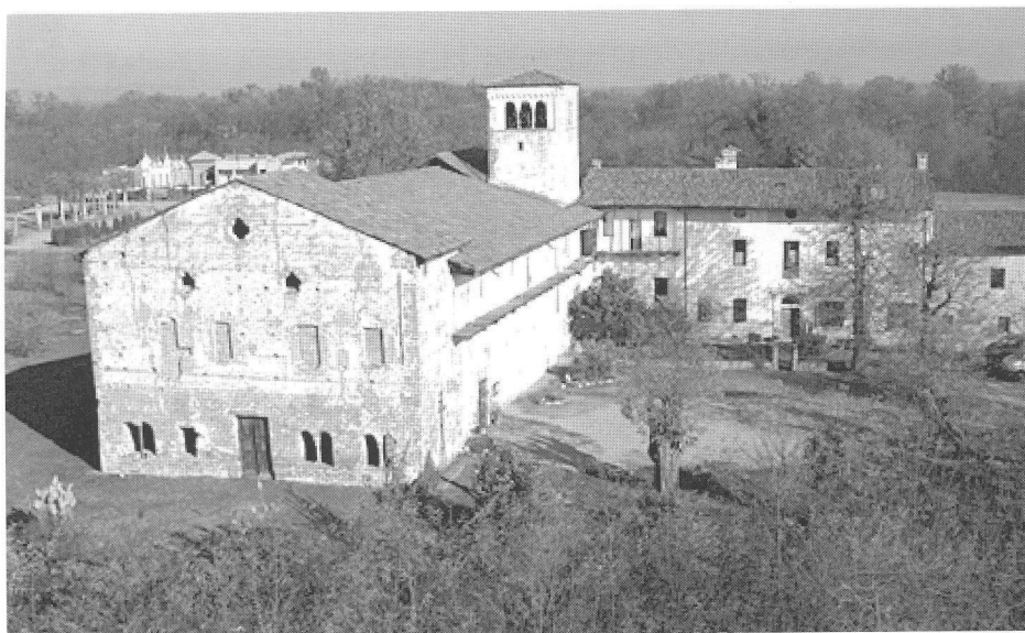
fig. 3 – Immagine aerea del complesso da sud-ovest (foto ing. Viazzo).
