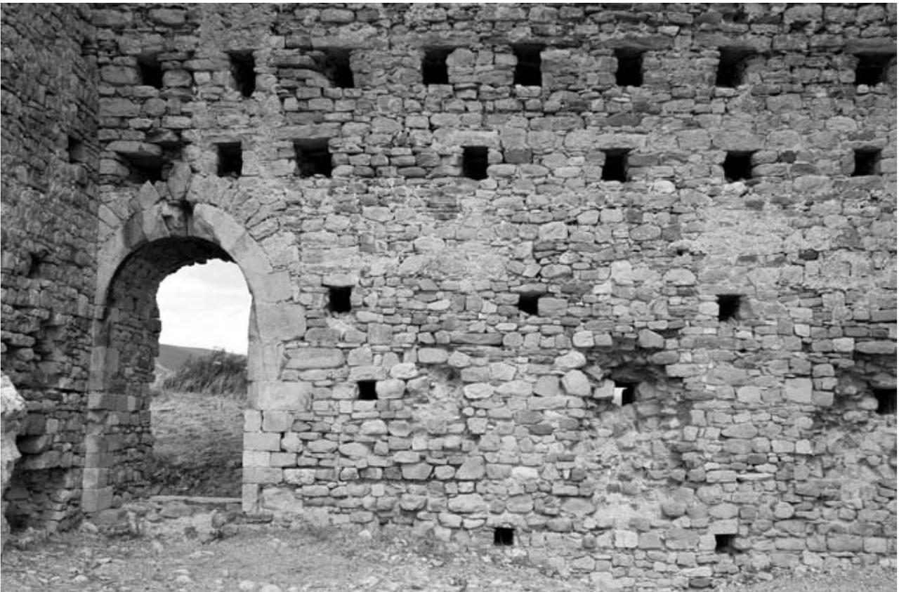
*fig. 10* – La parete interna settentrionale con la doppia fila di incavi realizzati per l'alloggio della centina.
