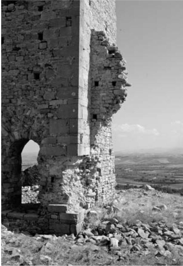
fig. 19 – Il tratto murario (USM 7) innestato nella parete ovest della torre.
