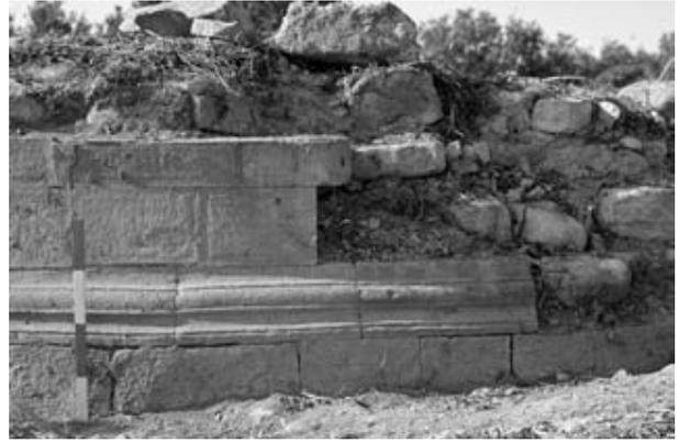
fig. 31 – Particolare della cornice modanata che corre lungo l'abside della cappella.
