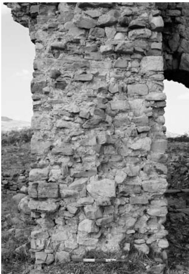
fig. 13 – Il nucleo della muratura occidentale della torre, apparecchiato in bancate.
