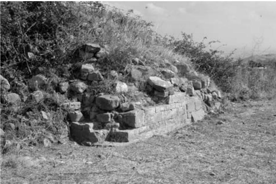
*fig. 25* – Struttura della torre di facciata settentrionale con profilo a scarpa.
