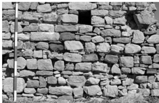
fig. 14 – Particolare della cortina orientale della torre.
