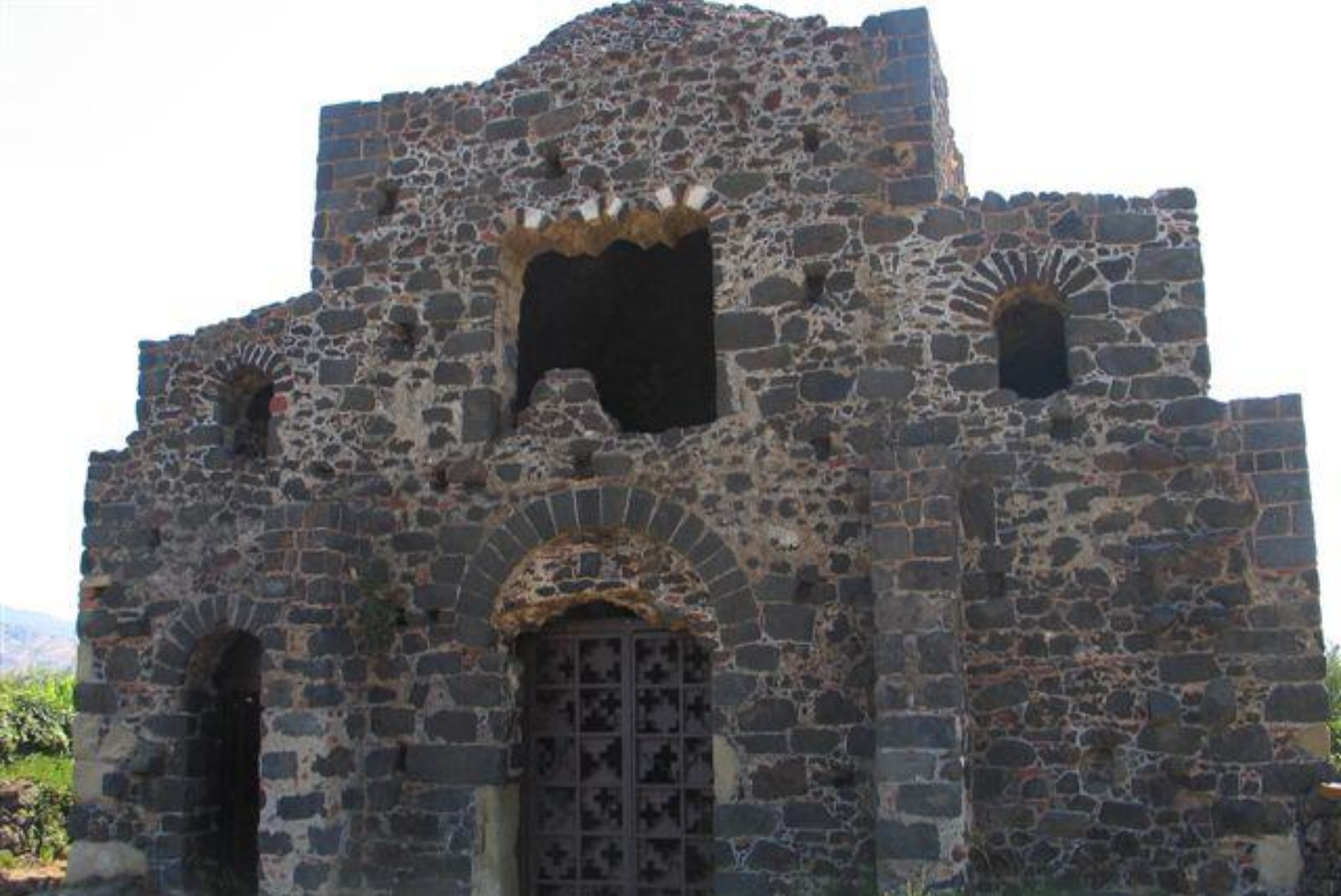
Castiglione di Sicilia (Messina). Chiesa di Santa Domenica: facciata
