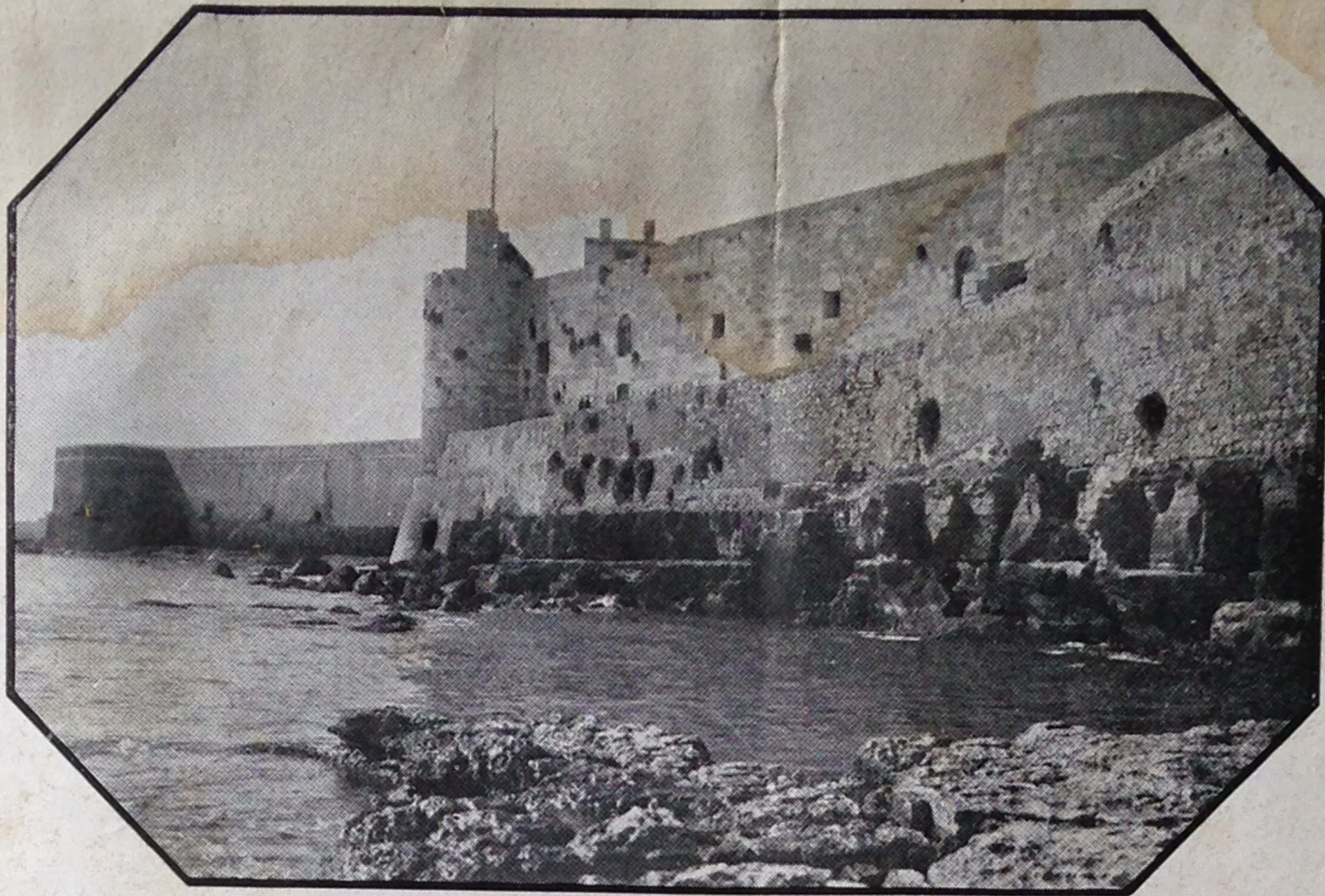
Lato di nord-est.
