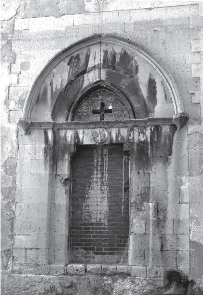
Fig. 17 - Finestra settentrionale della chiesa di S. Tommaso Apostolo (foto M. Agnello)
