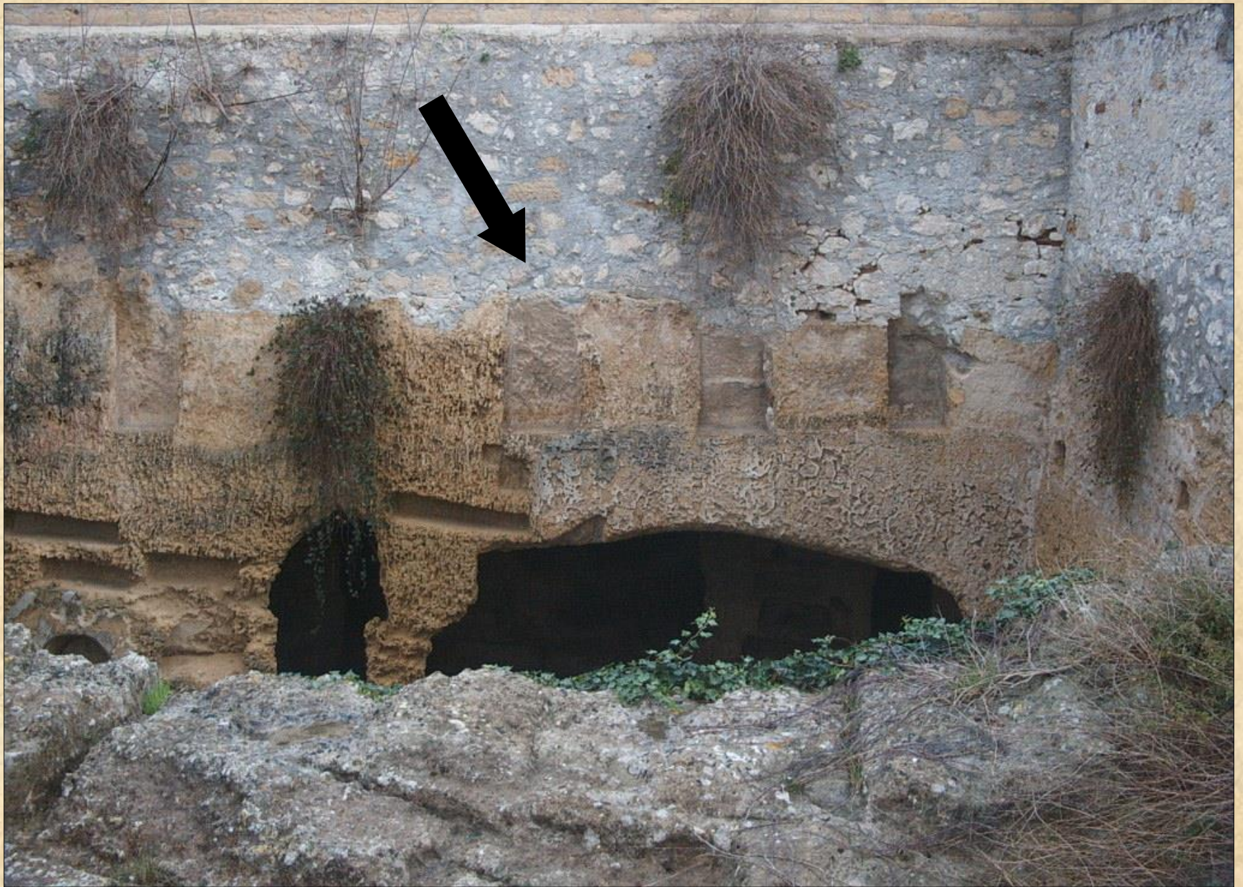
Cimitero di San Diego, vestibolo: incavi per copertura
