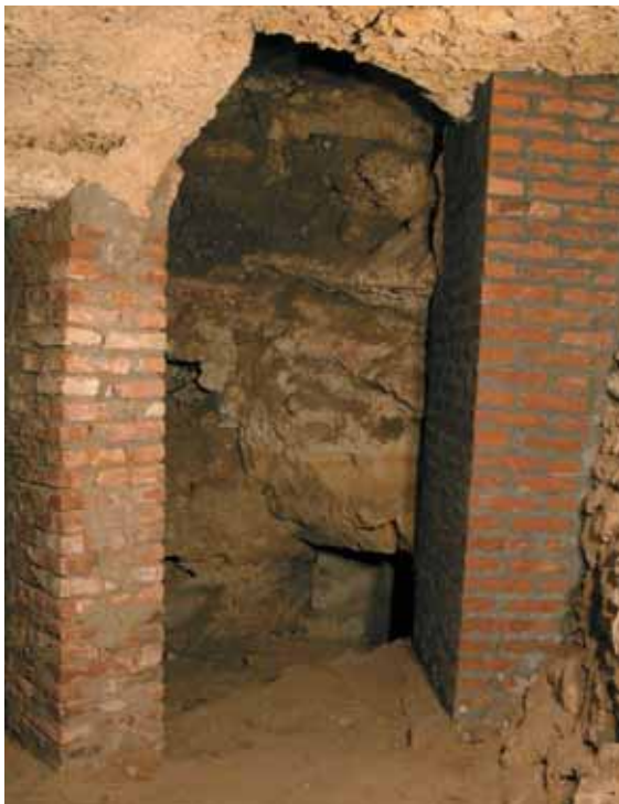
16 Regione C, pilastri in mattoni pressati
