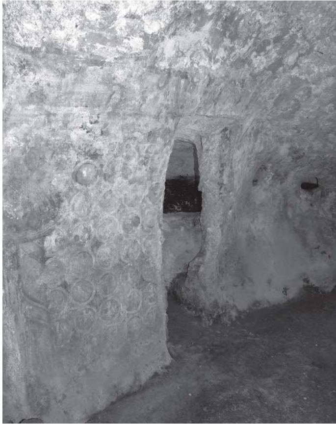
Fig. 22 - Cappella dell'Immacolata, la porta che immette nell'ambiente laterale.
