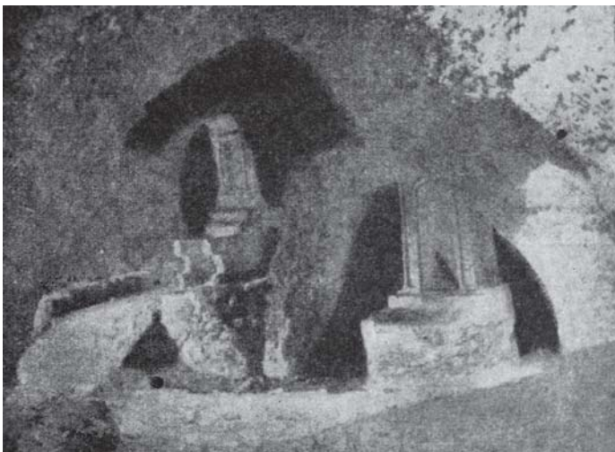
Fig. 13 - La cappella del Salvatore e il sacello adiacente nel 1920.
