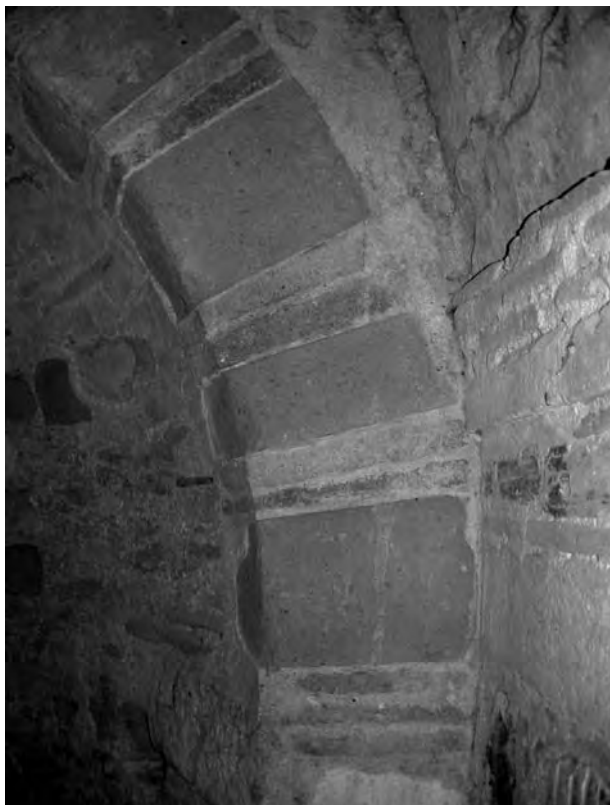
Fig. 30. Abside sinistra della chiesa di VIII-IX secolo, particolare della muratura in opus vittatum mixtum .
