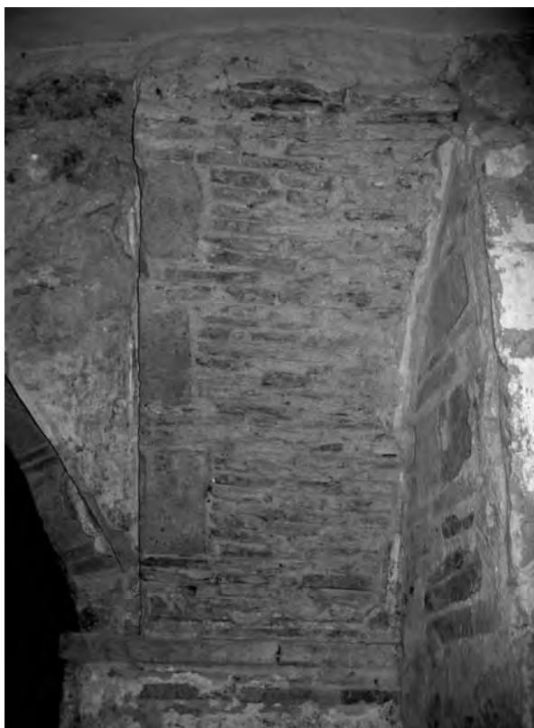
Fig. 35. Archi della cripta di XI-XII secolo, particolare della muratura.
