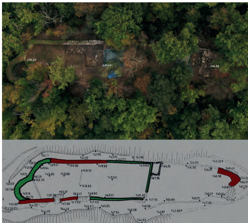
Fig. 3: Veduta generale sito. Le strutture campite in rosso appartengono alla fase di XII secolo, mentre l'attività ricostruttiva è evidenziata in verde. Foto da drone: Fabrizio Bracco (2018).
