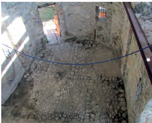
Fig. 3: Interno dell'edificio all'avvio degli scavi, nel 2016. La pavimentazione ad acciottolato dell'ultima fase costruttiva è databile al XIX/XX secolo.
