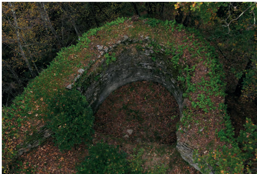
Fig. 4: Particolare della torre nord. I documenti d'archivio indicano che la sua costruzione è stata commissionata a "mastro" Taddeo, nel 1431. Foto da drone: Fabrizio Bracco (2018).
