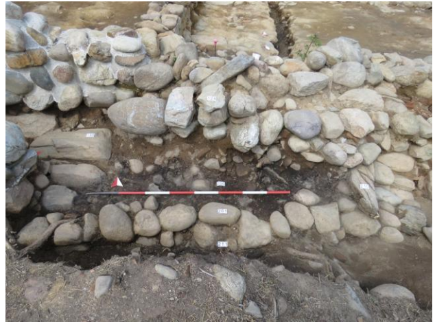
Fig. 7. Preesistenze a sud del perimetrale meridionale (da sud).
