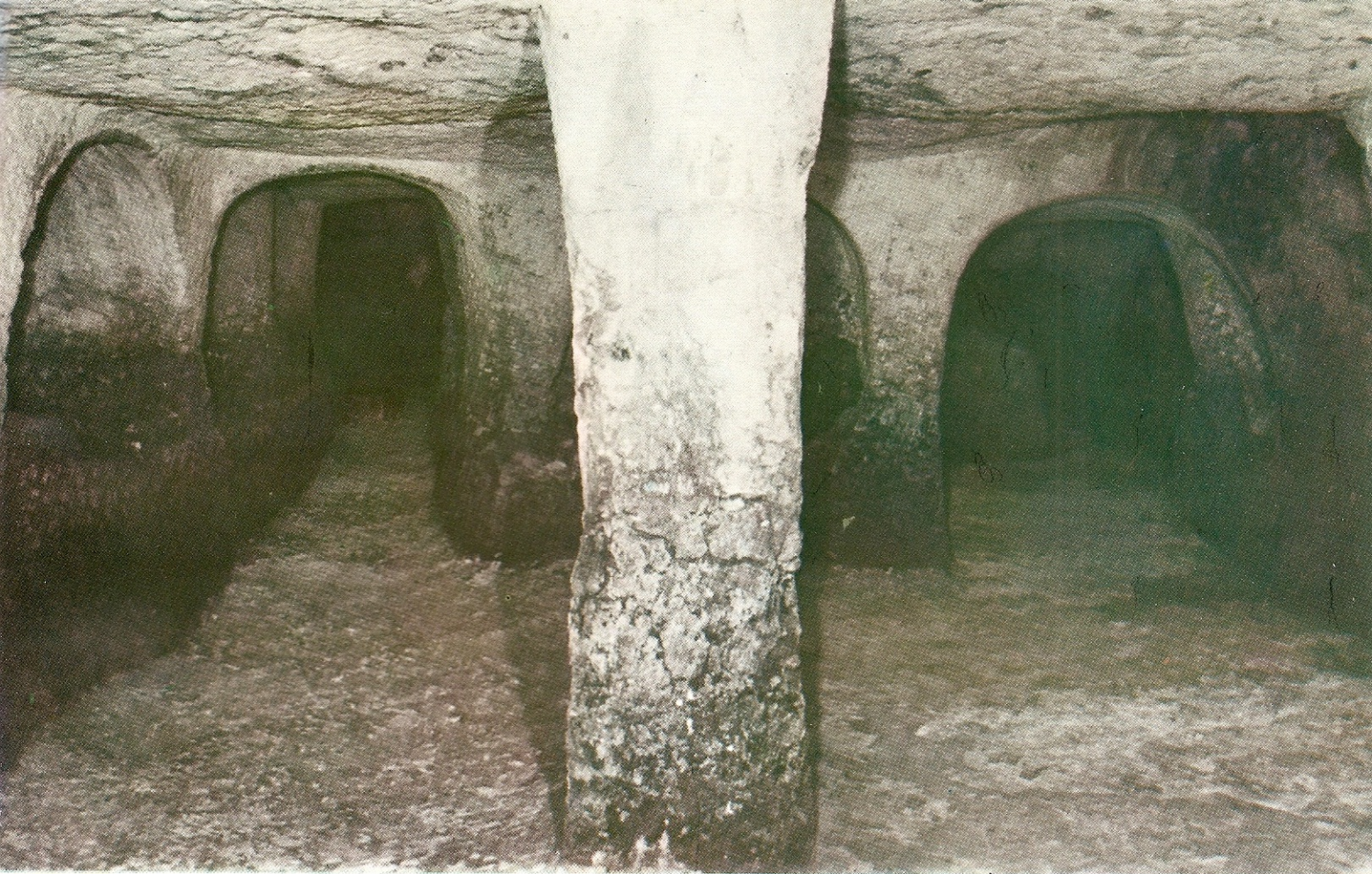
Galleria di accesso dopo il restauro
