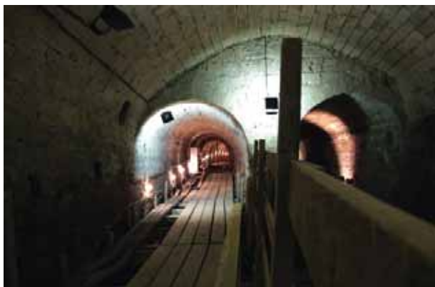
(Fig. 7) Il cosiddetto “tunnel dei crociati”, fotografato durante i lavori di recupero e valorizzazione, prima dell’apertura alla fruizione turistica. Il tunnel consentiva il passaggio tra il quartiere dei Templari e la zona del porto (Foto F. Benente).
