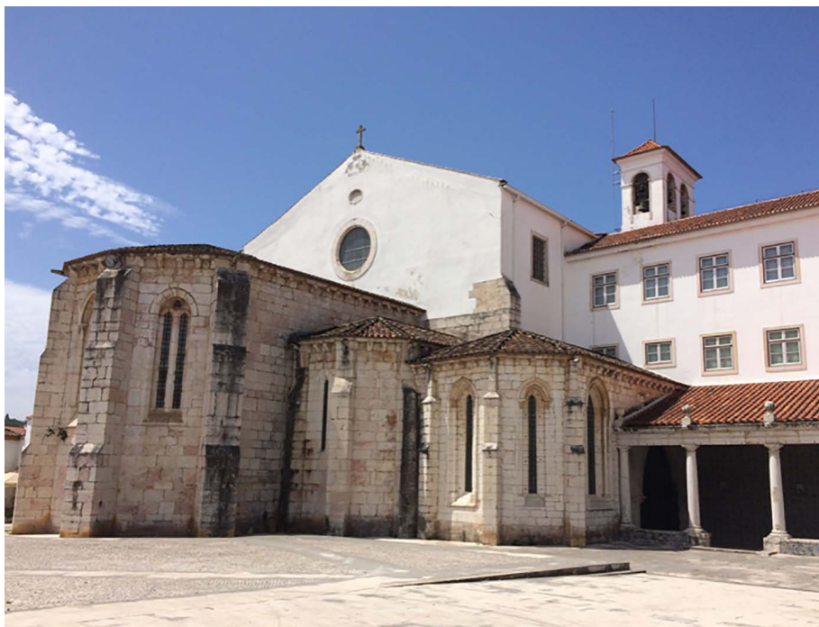
Fig. 2 Chiesa di São Dinis, Odivelas.
