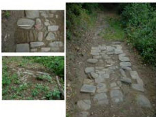
fig.2 Tratto di strada tra la chiesa di San Michele di Cetica e il ponte di Sant'Angelo sul Solano (CPSC 513) Tratto di lastricato con particolari di interventi recenti di manutenzione.
