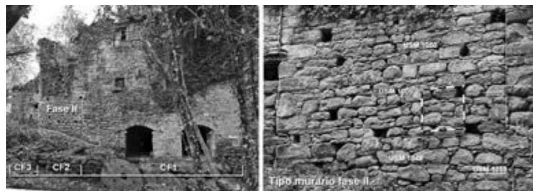
Fig. 4, La costruzione della casa del mugnaio (CF 2, PG 1, fase II) e relativa la tipologia muraria.
