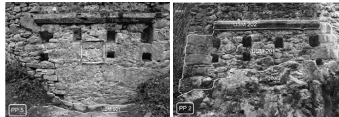
Fig. 4, I due prospetti alla base dell'arcata del ponte: il PP 5 sul lato sinistro del torrente e il PP 2 sul lato destro.
