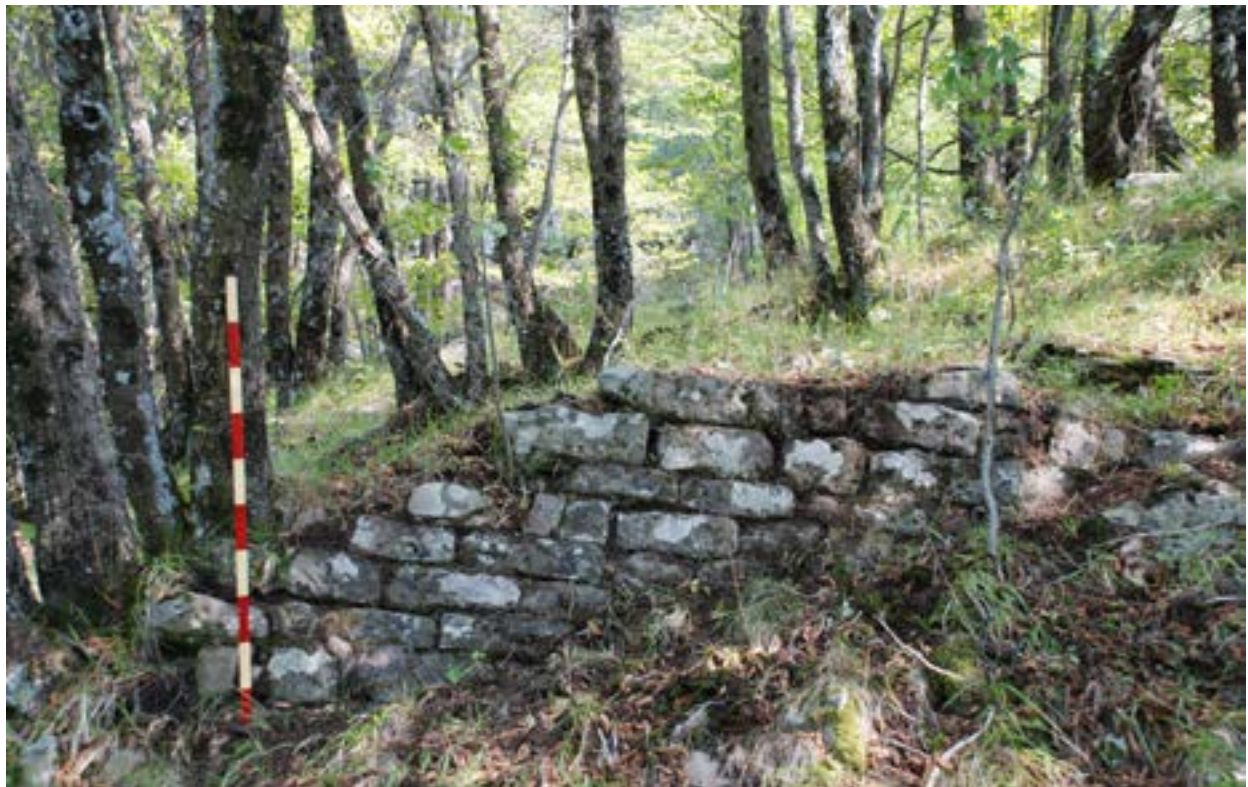
fig.4 Conventino. Murature della torre del castello.
