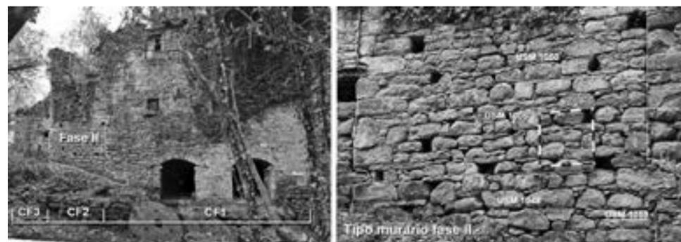
Fig. 4, La costruzione della casa del mugnaio (CF 2, PG 1, fase II) e relativa la tipologia muraria.
