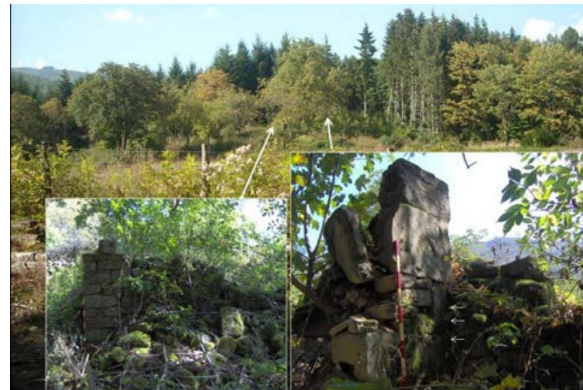
fig.2 Badia delle Pratora. Il pianoro coltivato in cui si collocano i ruderi della Badia. A sinistra le strutture rurali in uso nel XIX secolo. A destra lacerto murario dell'antica Badia con in evidenza conci di grandi dimensioni, quadrati e spianati su cui poggiano le murature 800'esche.
