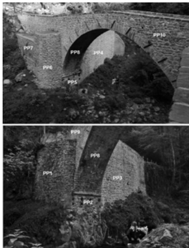
Fig. 1, Il ponte di Cetica dopo i restauri con i prospetti particolari indagati (PP): in alto il versante sinistro e in basso il versante destro.
