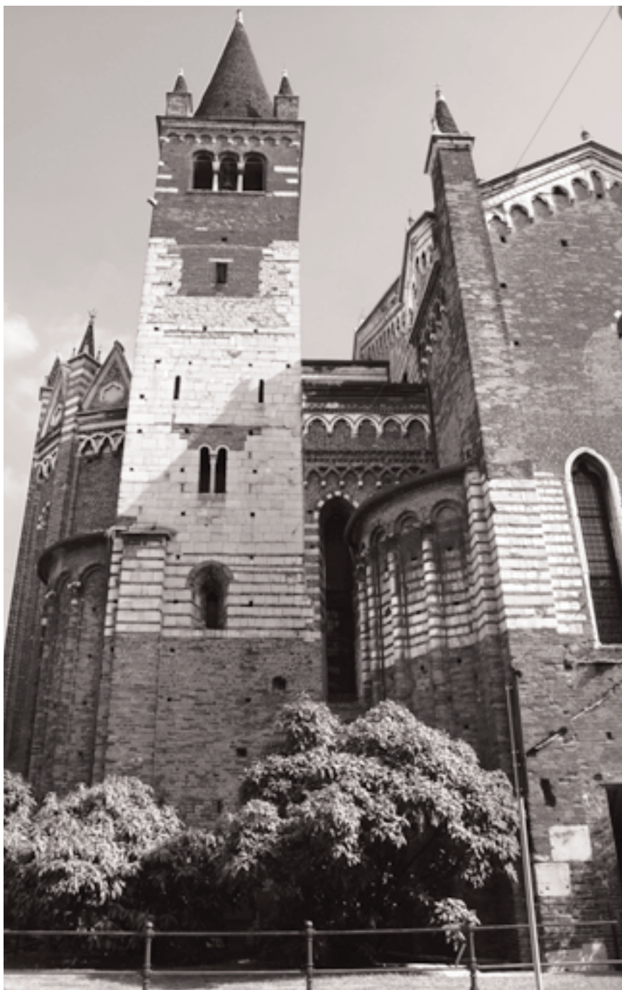
12. Verona, San Fermo, lato nord, torre campanaria.
