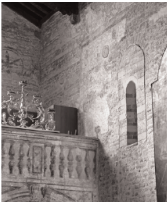
5. Verona, Sant'Elena, spigolo fra la controfacciata e il muro perimetrale nord.
