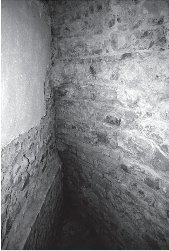
Fig. 5. La struttura di base dell'abside che taglia l'antico muro a scarpa.
