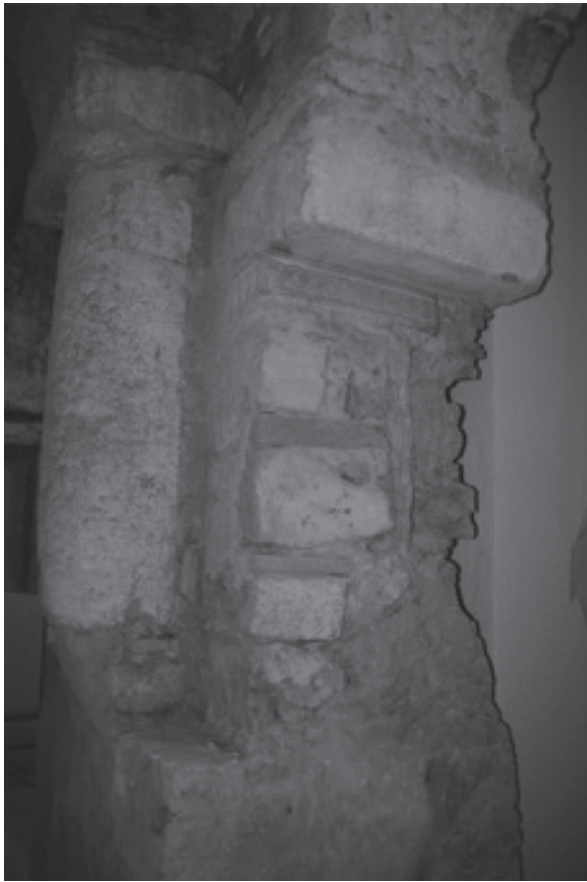
Fig. 17. Il pilastro composto dell'ala occidentale con l'evidente emersione della base di fondazione.
