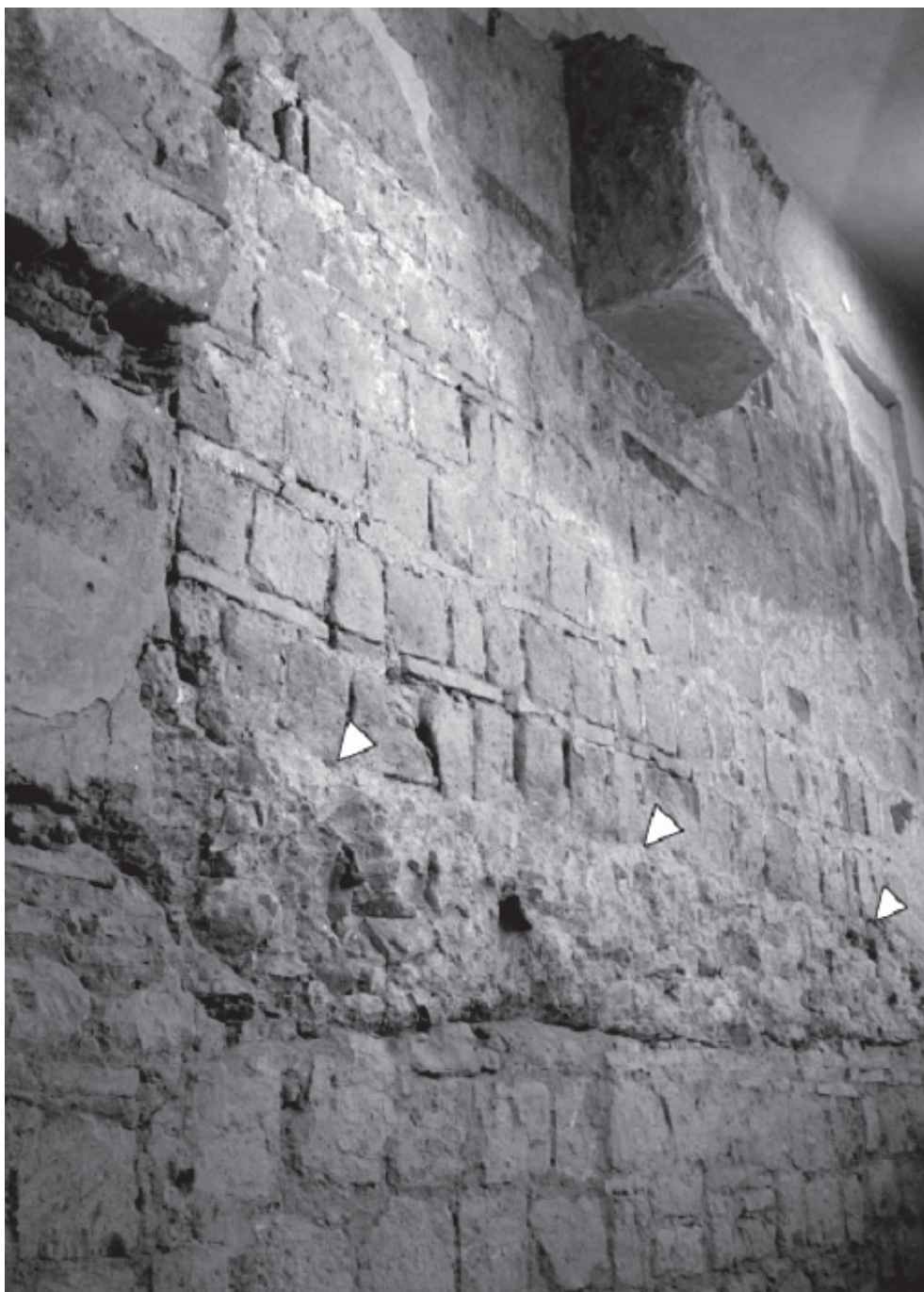
Fig. 13. La fodera muraria che fa da supporto al ciclo di affreschi dedicati a S. Barbato; si notino l'inserimento del getto di conglomerato su cui poggiava il pavimento e, in alto (a sinistra e a destra), i peducci su cui impostavano gli archi di collegamento strutturale.
