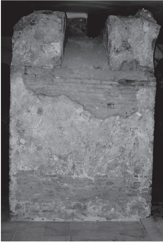
Fig. 14. Il pilastro di sostegno dell'altare con la fenestella confessionis .
