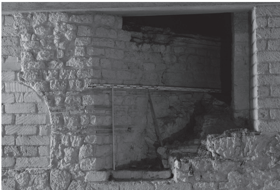
Fig. 7. S. Giovanni in Fonte: il lato esterno nord-ovest del tamburo, dove si intravede l'esterno della cuffia angolare. La finestra arcuata a sinistra è postantica.
