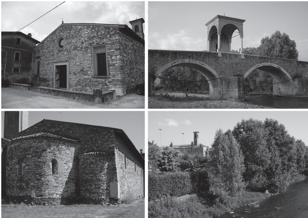
Fig. 9. Bedizzole, località Pontenove, pieve di S. Maria, ponte con edicola sacra e fiume Chiese.
