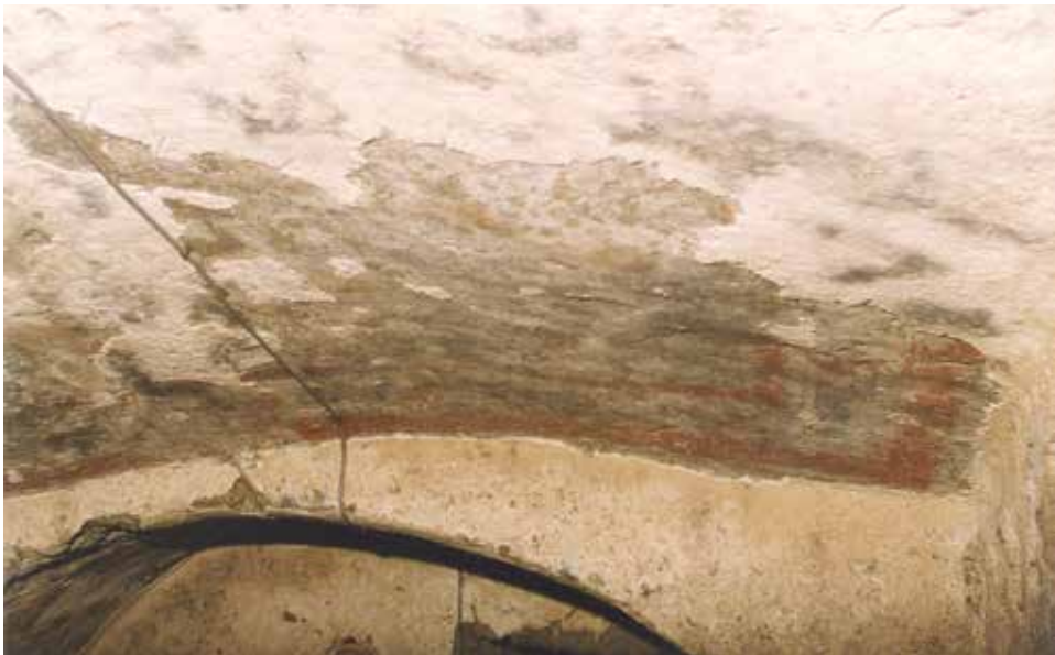
Fig. 7 – La volta dell'arcosolio B5 negli anni Novanta del secolo scorso (AICC, foto n. 1825).
