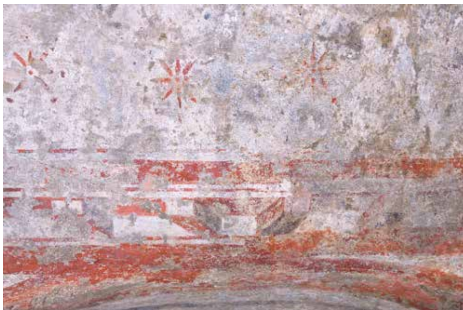
Fig. 22 – Volta del cubicolo B5, particolare, alla fine della seconda fase di restauro con pulitura laser (Foto F. Speranza).
