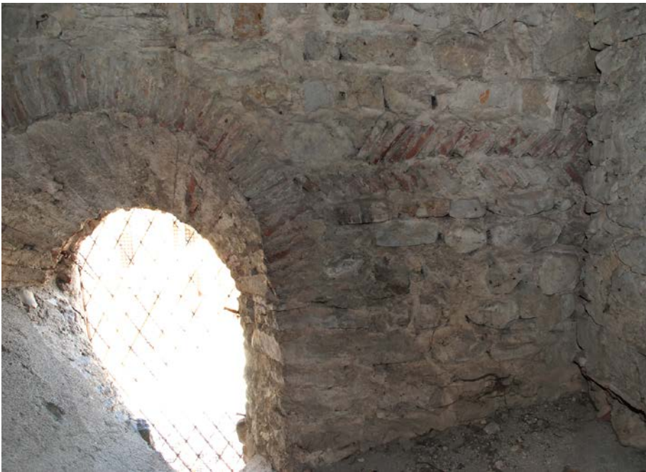
Fig. 8. Bobbio. Chiesa cattedrale di Santa Maria. Finestrato del lato nord, ghiera interna di una monofora.
