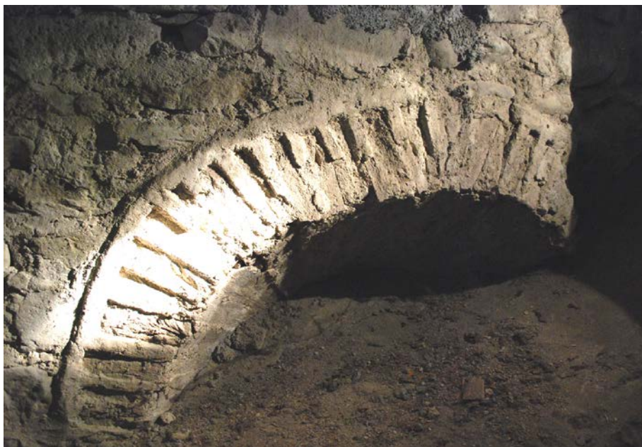
Fig. 9. Bobbio. Chiesa cattedrale di Santa Maria. Finestrato del lato sud, ghiera interna di una monofora occlusa.
