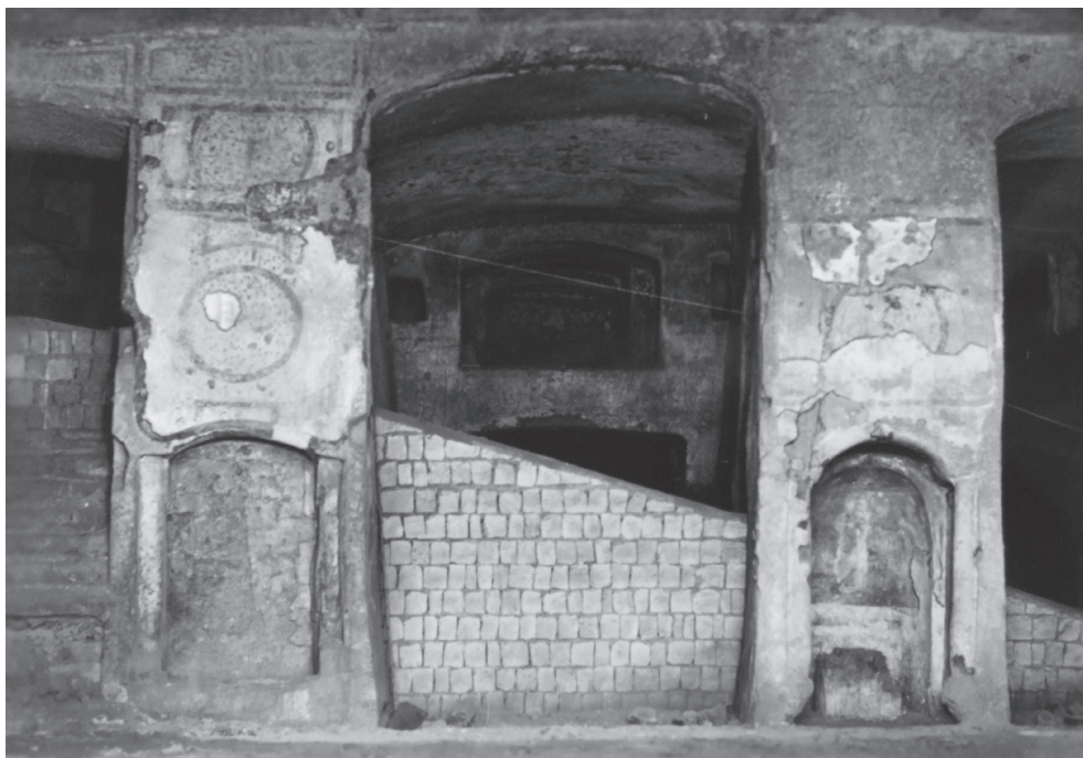
Fig. 6. 'Vestibolo inferiore' (B1) della catacomba di S. Gennaro con la rampa d'accesso al pronto soccorso antiaereo (tra il 1943 e il 1953).
