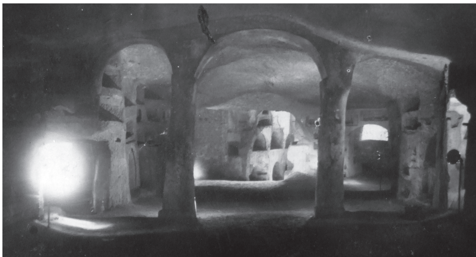
Fig. 12. Galleria A4 della catacomba di S. Gennaro; sullo sfondo, alle spalle del pilastro sinistro, la tamponatura dell'accesso alla 'cripta dei vescovi' (prima metà del Novecento).
