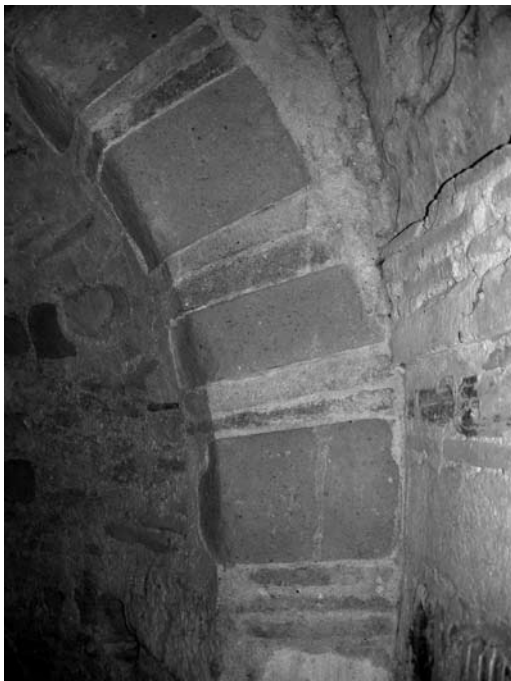
Fig. 12. Frigento, chiesa di S. Maria Assunta. Abside sinistra della chiesa di VIII-IX secolo, particolare della muratura in opus vittatum mixtum .
