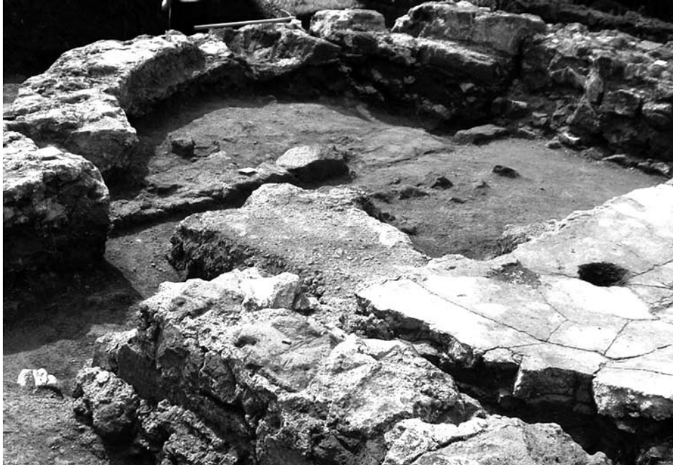
fig. 10. Avellino, castello. Resti dell'edificio di culto.
