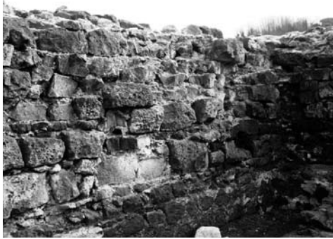
Fig. 7. Avellino, castello. Grande ambiente centrale, particolare di una delle cortine murarie con ricorsi di nastrini.
