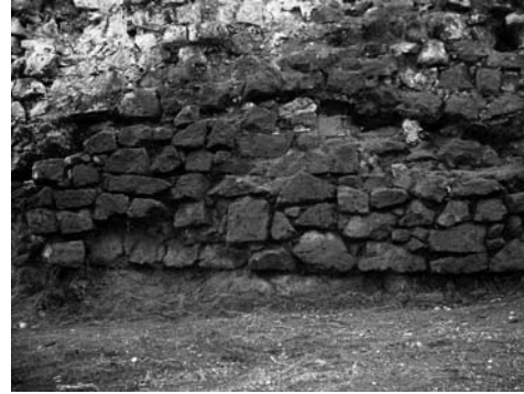
Fig. 8. Avellino, castello. Particolare delle murature di età altomedievale, lungo il perimetro settentrionale.
