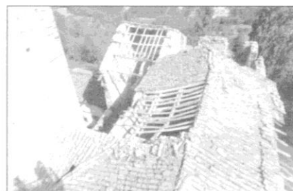
Fig. 4 - Olmo Gentile, castello - copertura ala est
