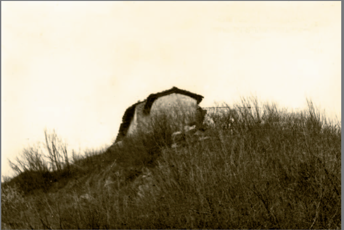
Castione della Presolana, la chiesa di S. Pietro (S. Péder), interno ed esterno prima dei lavori di restauro del 1974 (foto Biagio Piccardi).
