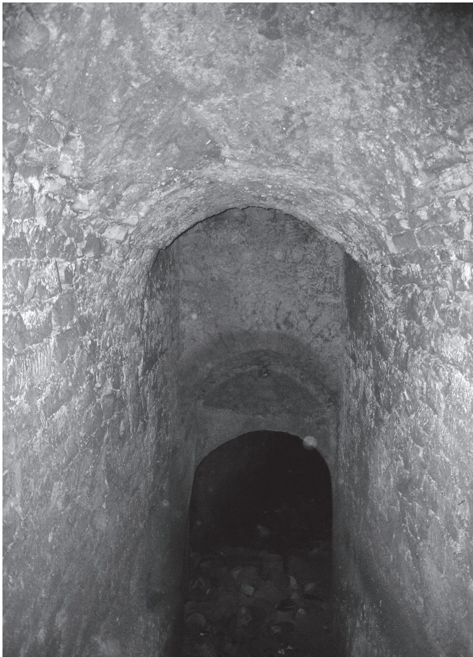
Fig. 95. Comiziano, cantina C8. Volta in muratura della scala.
