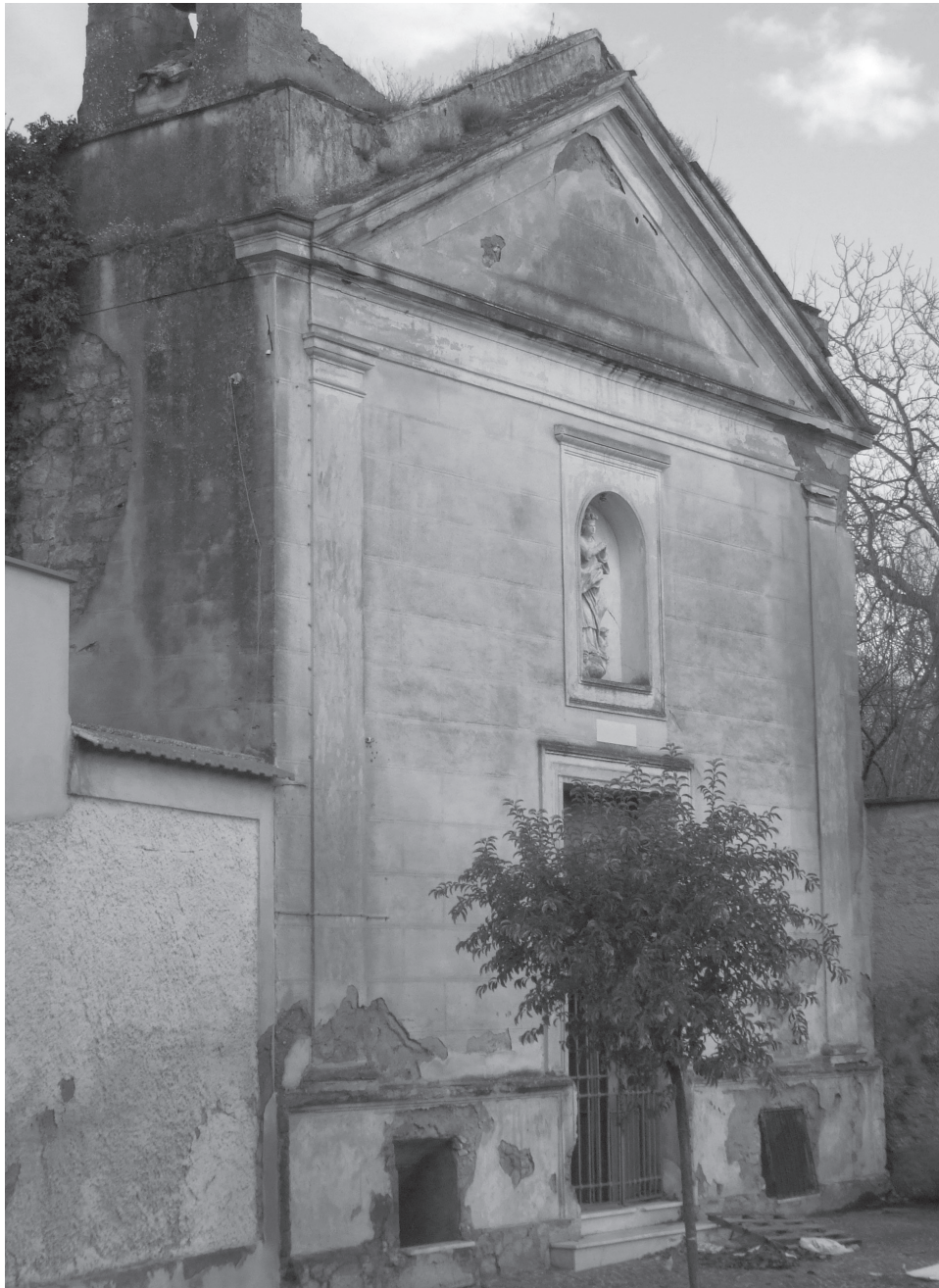
Fig. 63. Chiesa dell'Immacolata, facciata.
