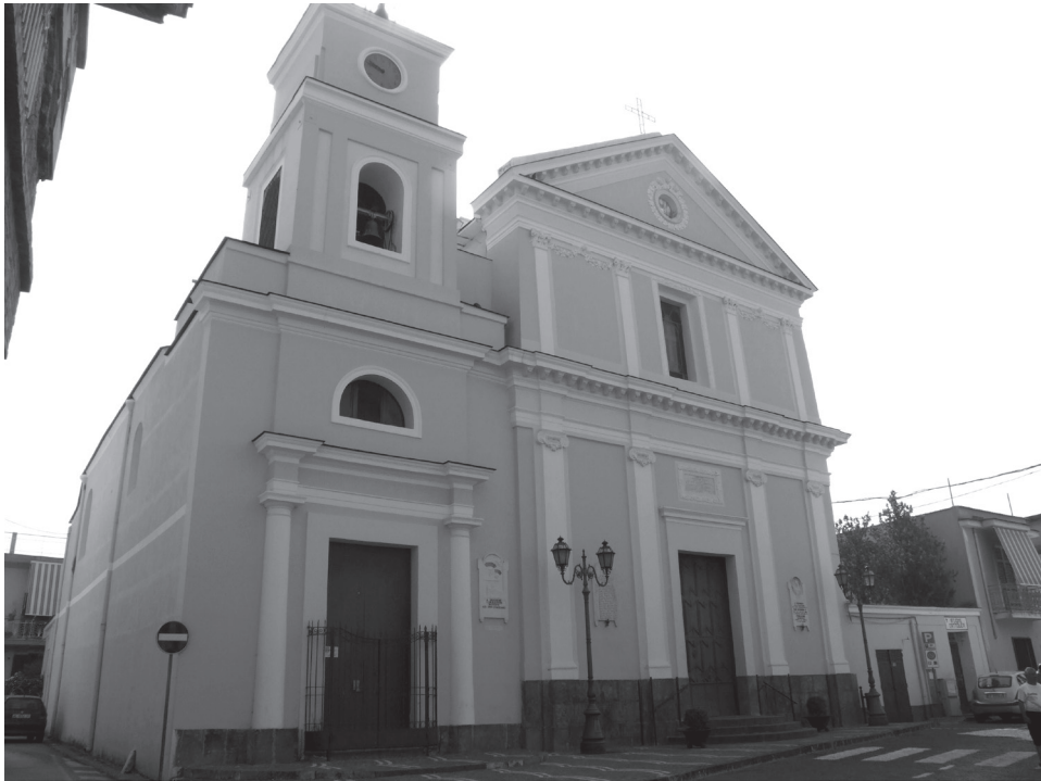
Fig. 34. Congrega del SS. Rosario (già chiesa di S. Maria delle Grazie) e parrocchiale di S. Severino, facciate e campanile
