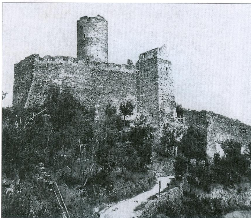
Fig. 10 – Il Castello del Monte Ursino a Noli, in una ripresa fotografica del 1966 (Bordighera, Archivio Fotografico dell'Istituto Internazionale di Studi Liguri, n. 25179).
